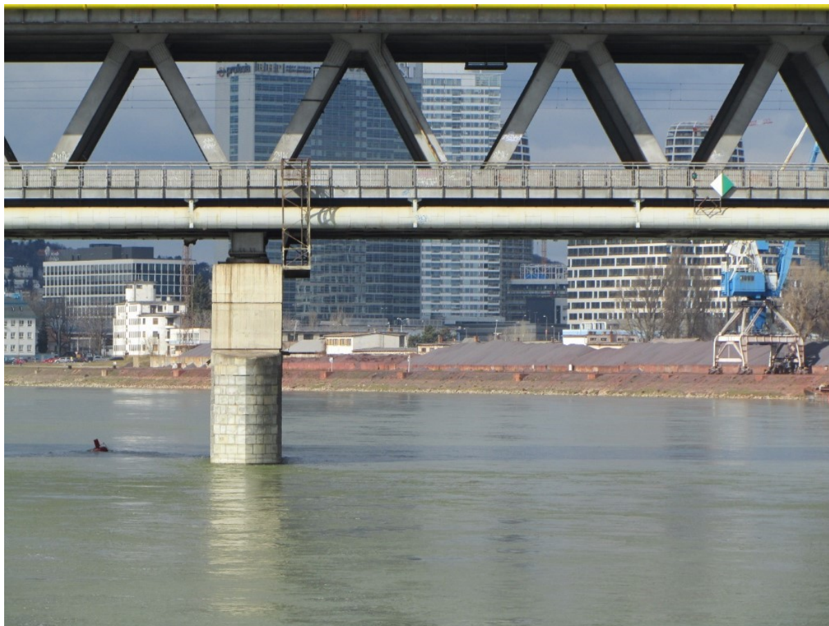
Obrázok 27. Prístavný most s neoznačeným pilierom
