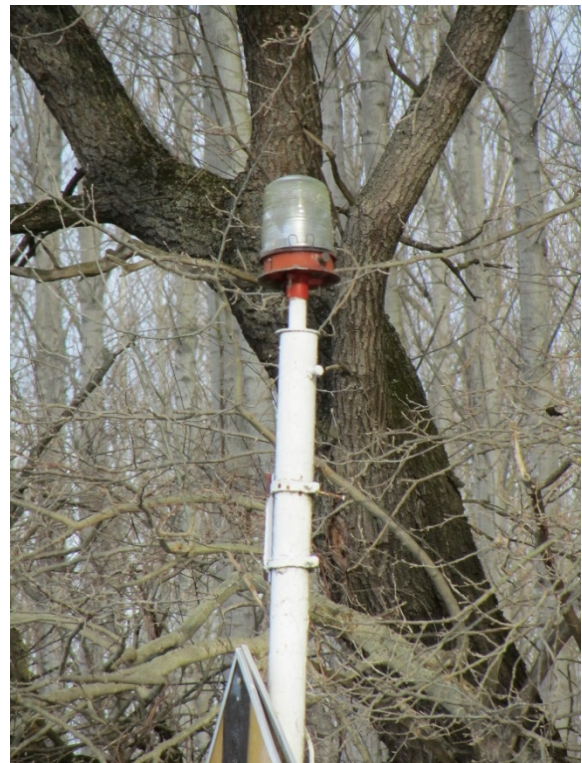
Obrázok 44. Prechodový znak so starším typom svetidla a znakom z retroreflexného materiálu
