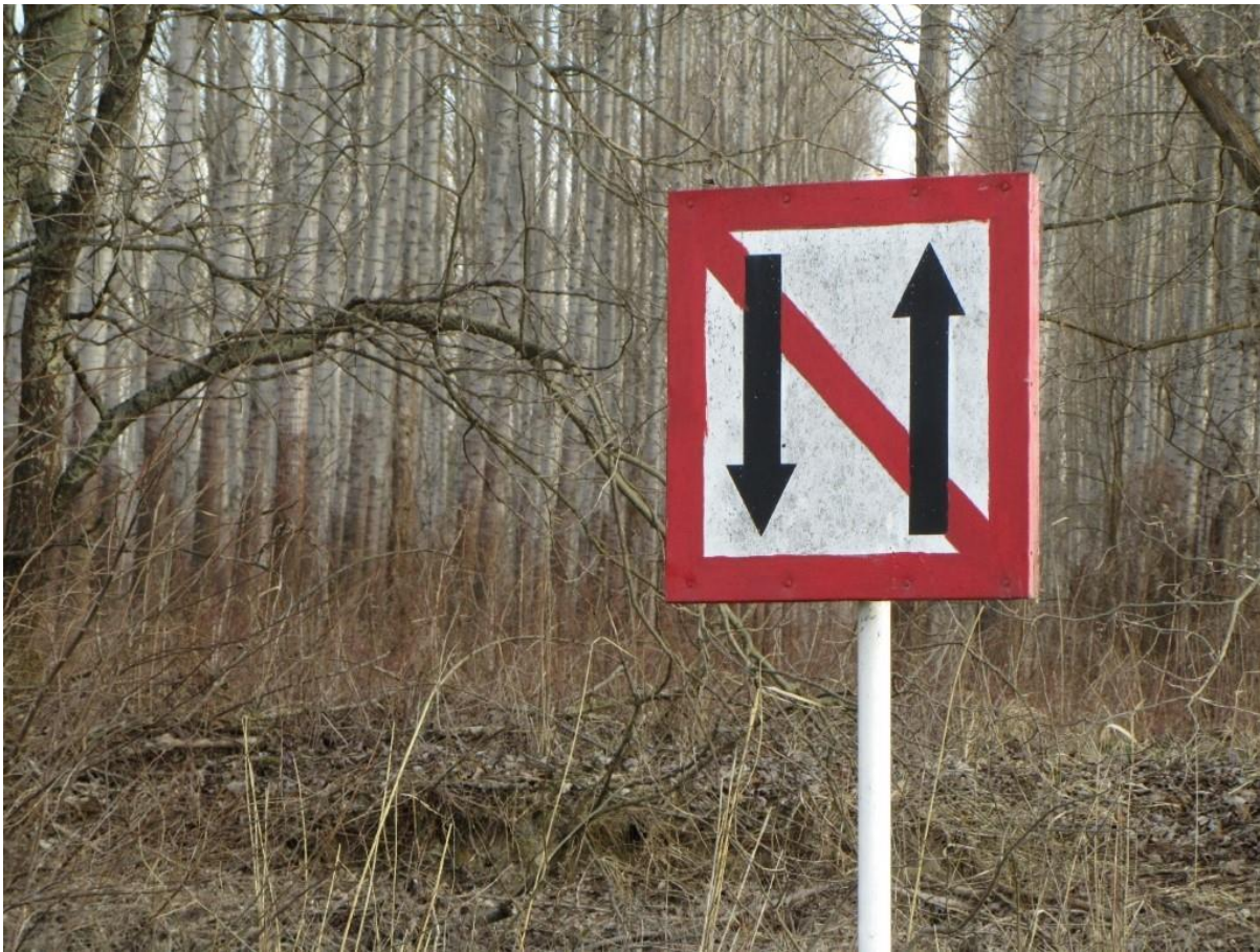
Obrázok 13. Znak A4 (nedostatočná veľkosť)
