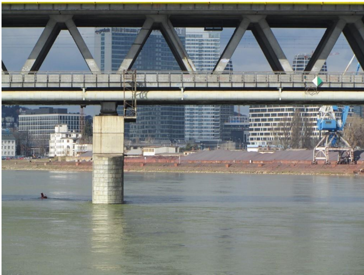
Obrázok 27. Prístavný most s neoznačeným pilierom
