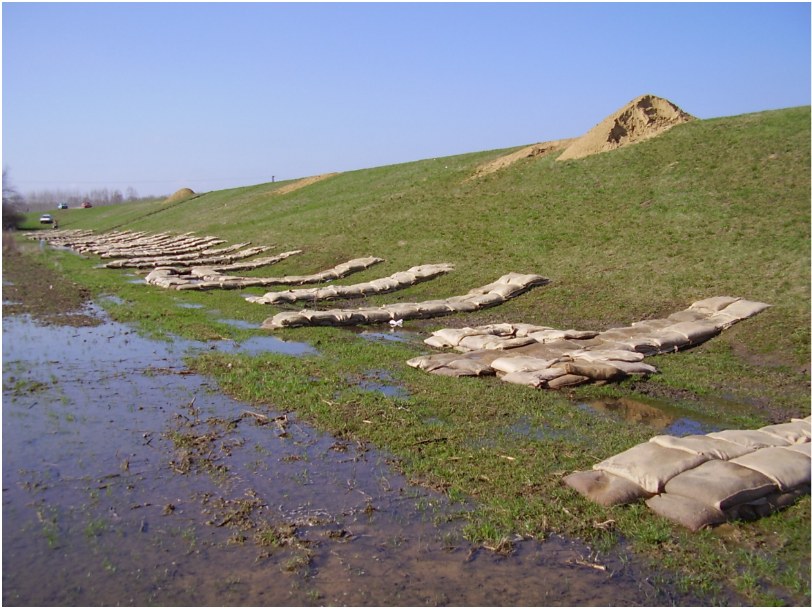
Obr. 2: situácia na vzdušnej strane hrádze počas povodňového stavu v roku 2006.
