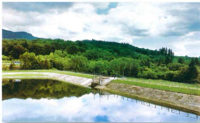
Hrádza vyrovnávacej nádrže pod Dobšinou
