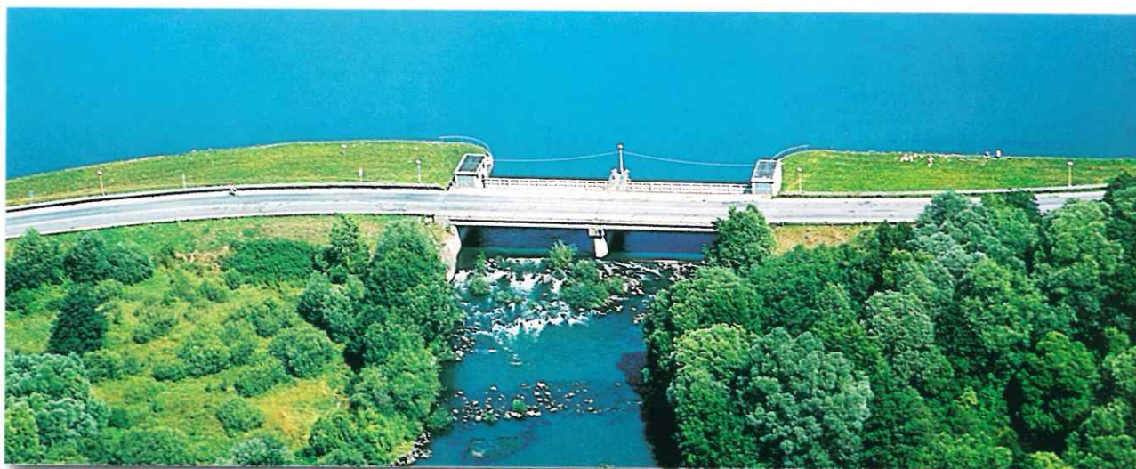
Hať vyrovnávacej nádrže Malá Domaša
