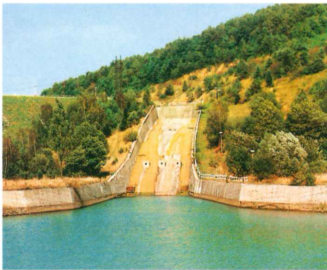
Bezpečnostný priepad akumuláčnej nádrže
