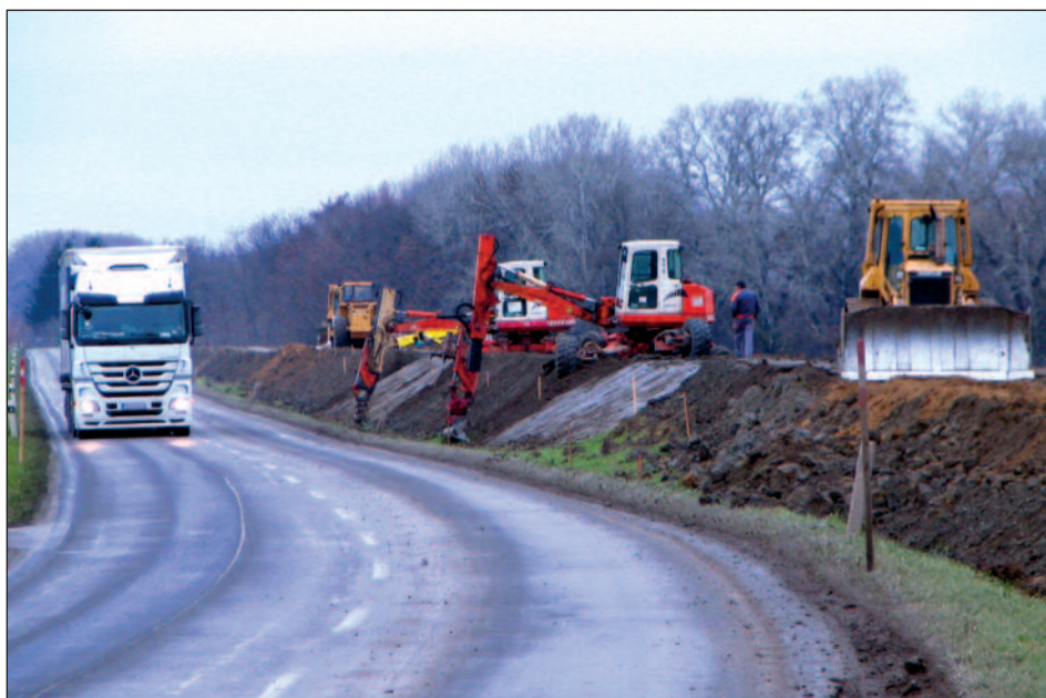
Práce na Výstavbe ochrannej hrádze na rieke Čierna voda, Trstice – Kráľov brod Stavba sa realizovala od roku 2009 do roku 2015 vlastnými kapacitami SVP, š.p.
