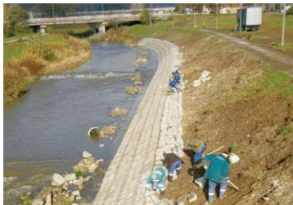
Oprava opevnenia koryta Torysy v Prešove
