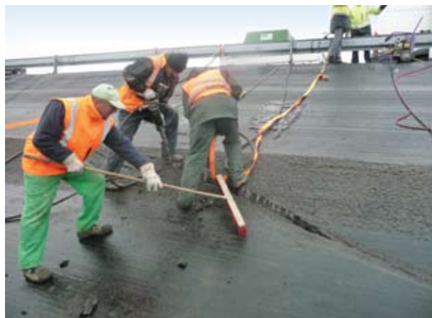
Oprava poškodeného asfaltobetónového plášta ľavej strany prírodného kanála do Gabčíkova v októbri 2013
