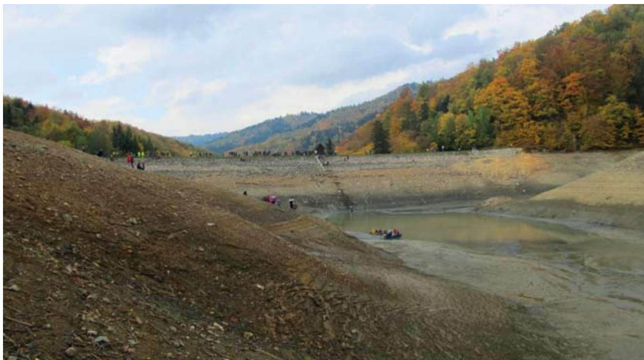
Vypustený Dolnohodušký tajch pred začiatkom rekonštrukcie
