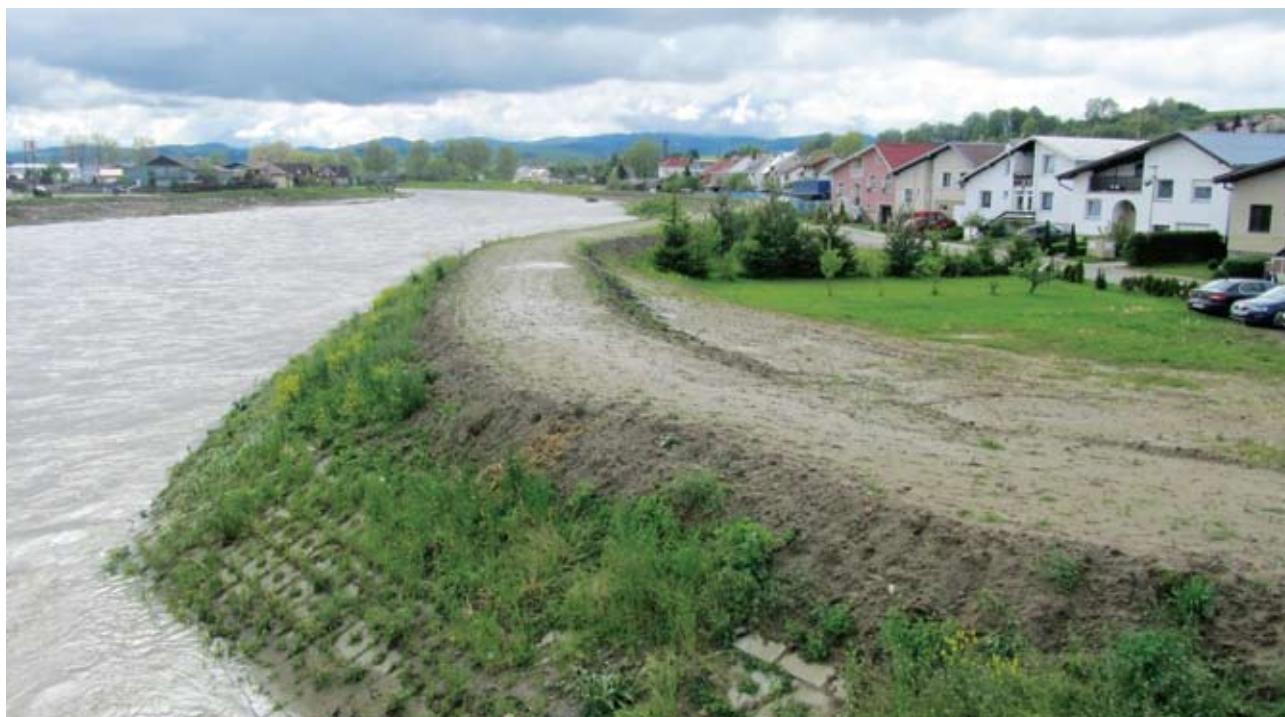
Nová ochranná hrádza v Starej Ľubovni
