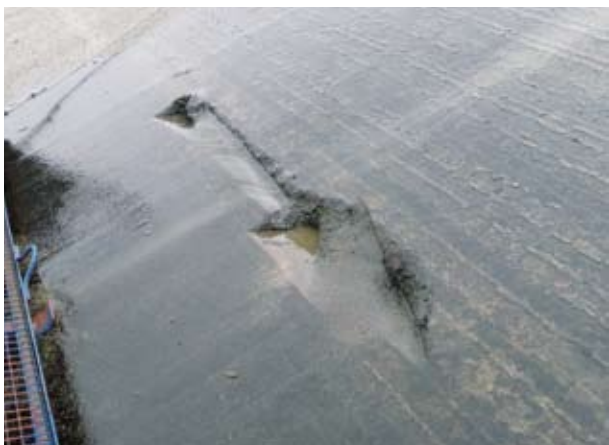
Po náraze neznámou loďou vznikli na asfaltobetónovom plášti prírodného kanála do Gabčíkova takéto trhliny
