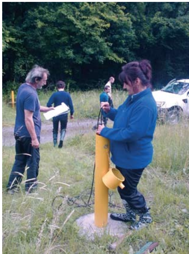
Kontrola pozorovacej sondy v rámci technicko-bezpečnostného dohľadu
