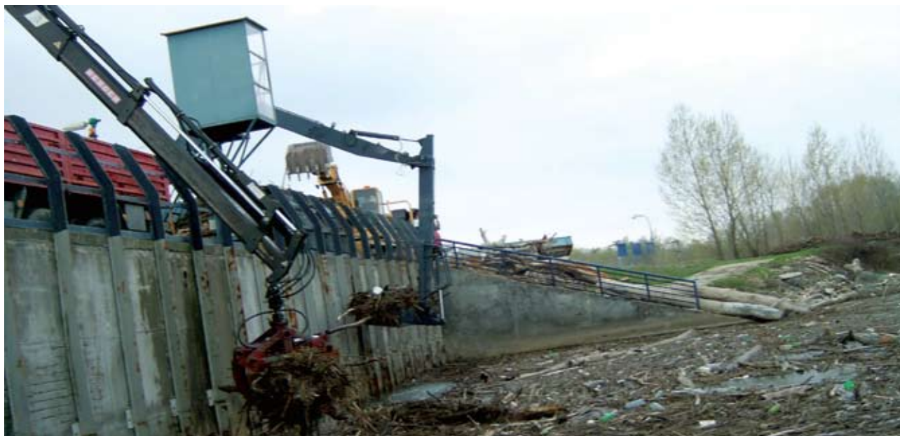
Naplaveniny na odbernom mieste zo zdrže Hrušov do Mošonského ramena treba pravidelne odstraňovať pomocou týchto mechanizmov
