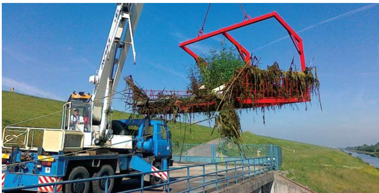
Odstraňovanie naplavenín na priepuste Vodného diela Gabčíkovo
