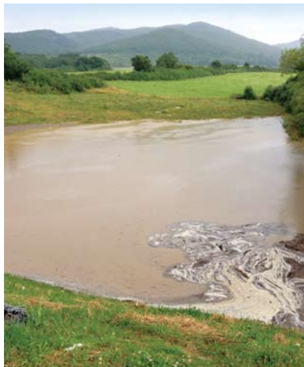
Nový polder nad obcou Dobrá Niva 1. augusta 2014 ukázal naplno svoju funkčnosť, keď počas bleskovej povodne ochránil obec pred väčšími povodňovými škodami
