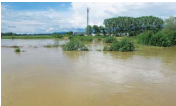
Zaliaty medzihrádzový priestor na Toryse v Sadoch nad Torysou, kde navýšenie a úprava hrádze už počas májovej povodne intravilán obce ochránili
