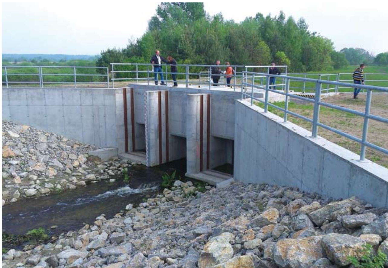
Zátvorný objekt na Lakšárskom potoku zvyšujúci bezpečnosť obce Malé Leváre
