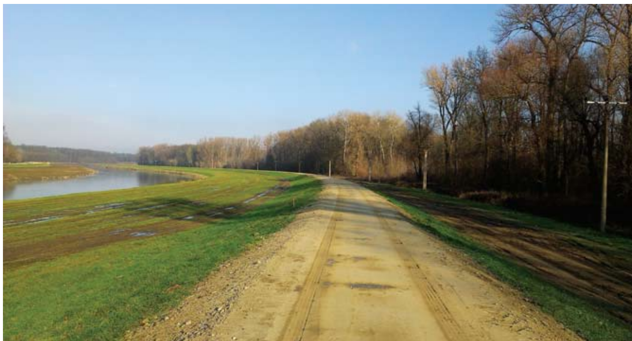
Dorovnanie 4300 metrového úseku ľavej ochrannej hrádze Moravy
