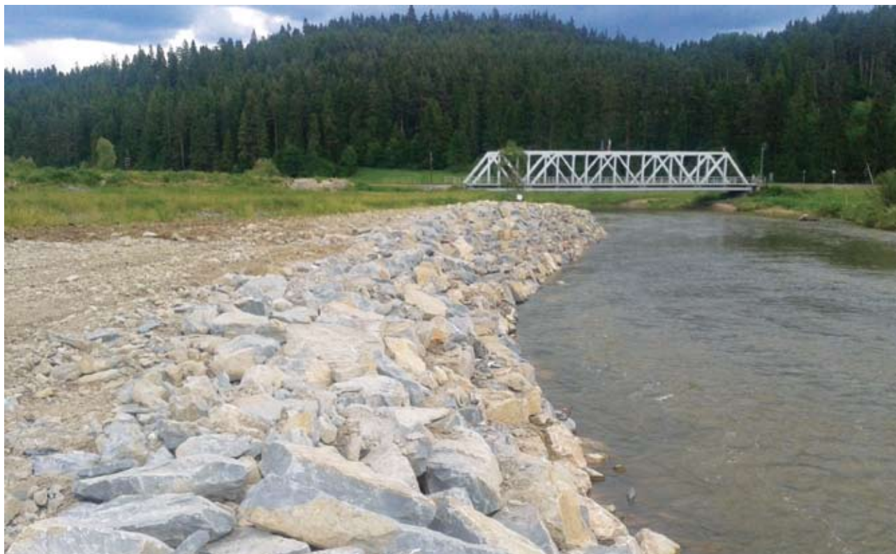
Rieka Poprad v Spišskej Belej po skončení vodohospodárskych zabezpečovacích prác - sanácii výmoľa
