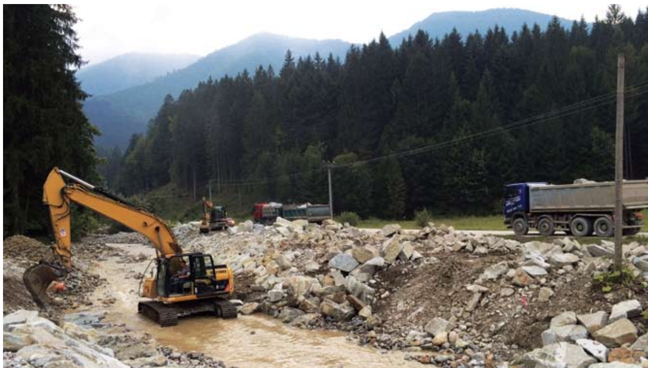
Na obnovovaní koryta a brehov Varínky - Vratňanky sa pracovalo nepretržite 4 mesiace
