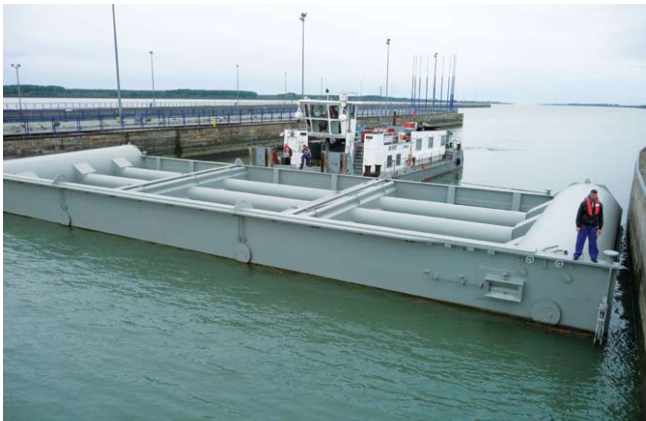
Zahradzovanie ľavej plavebnej komory VD Gabčíkovo
