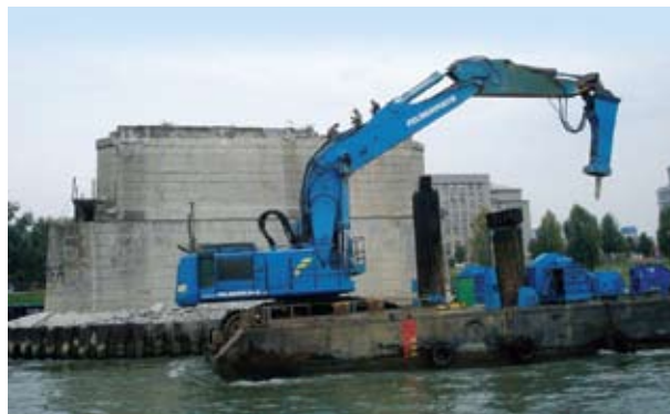
Búranie Starého mosta v Bratislave
