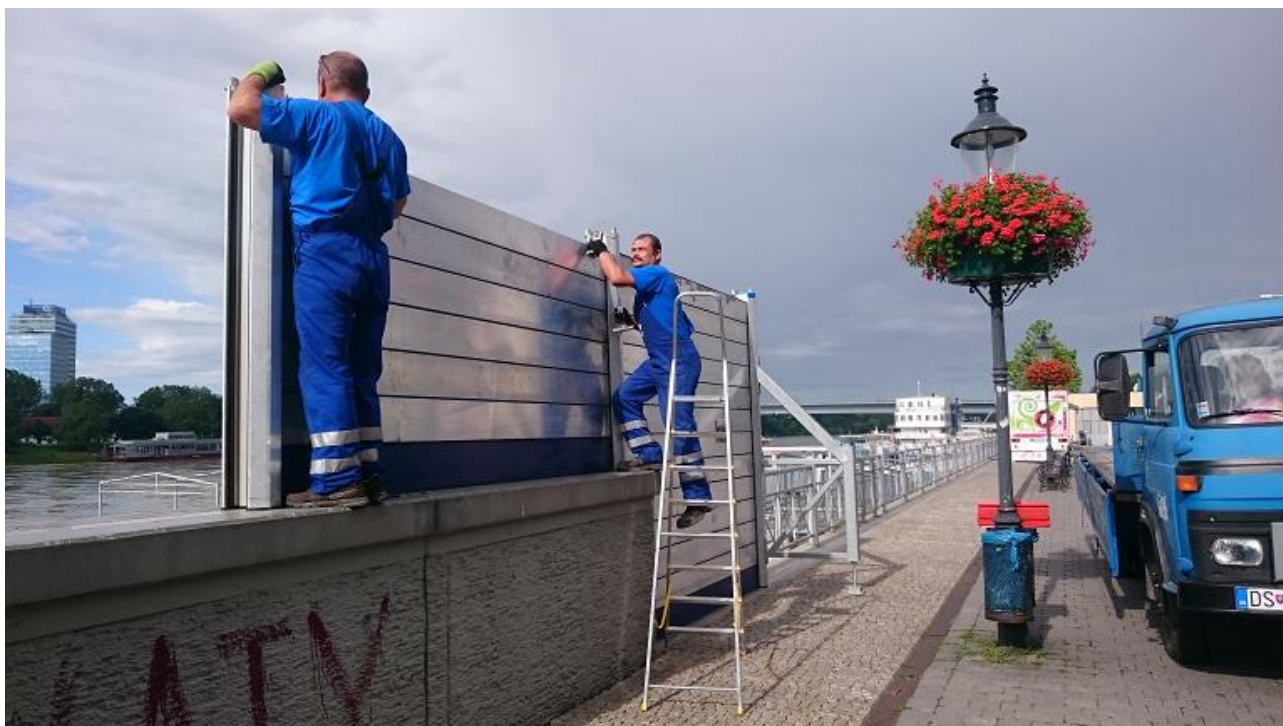
Inštalovanie mobilnej protipovodňovej ochrannej bariéry na nábreží Dunaja na Nám. Ľ. Štúra v Bratislave
