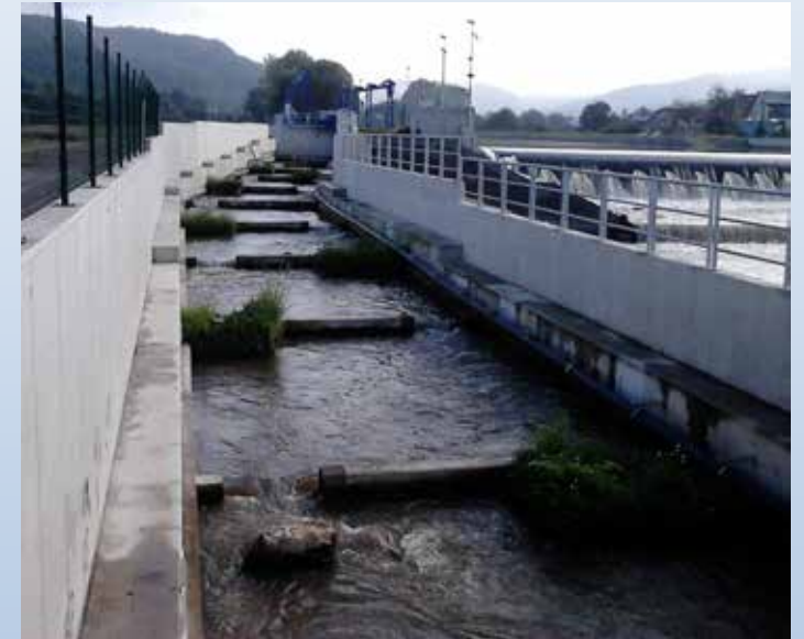
pravostranný obtokový prepážkový rybovod pri hati
