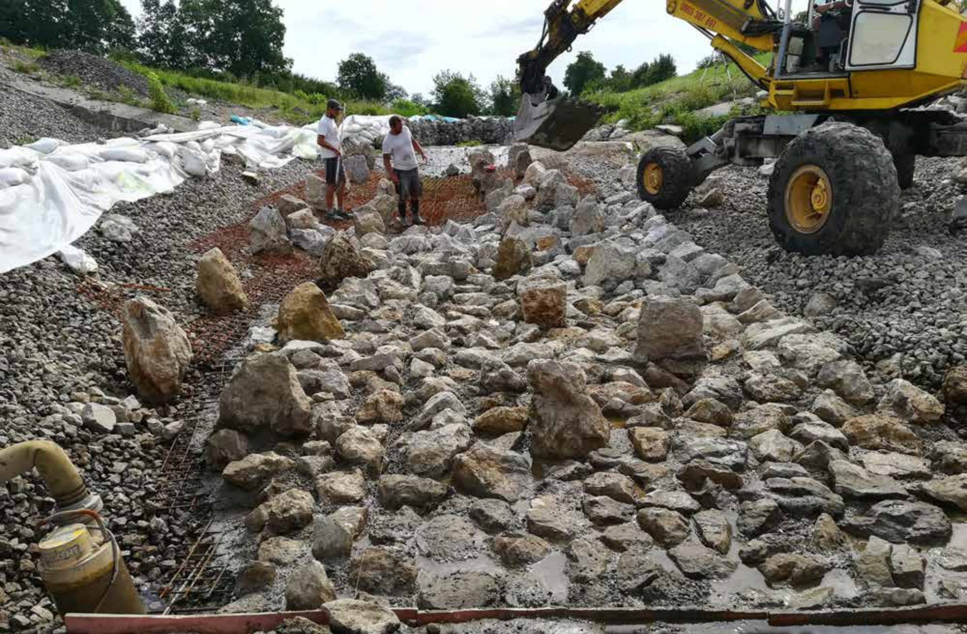
Pre členité dno- striedavé ukladanie vyšších a nižších balvanov + hlboké špáry. Nie prelievanie betónom!
