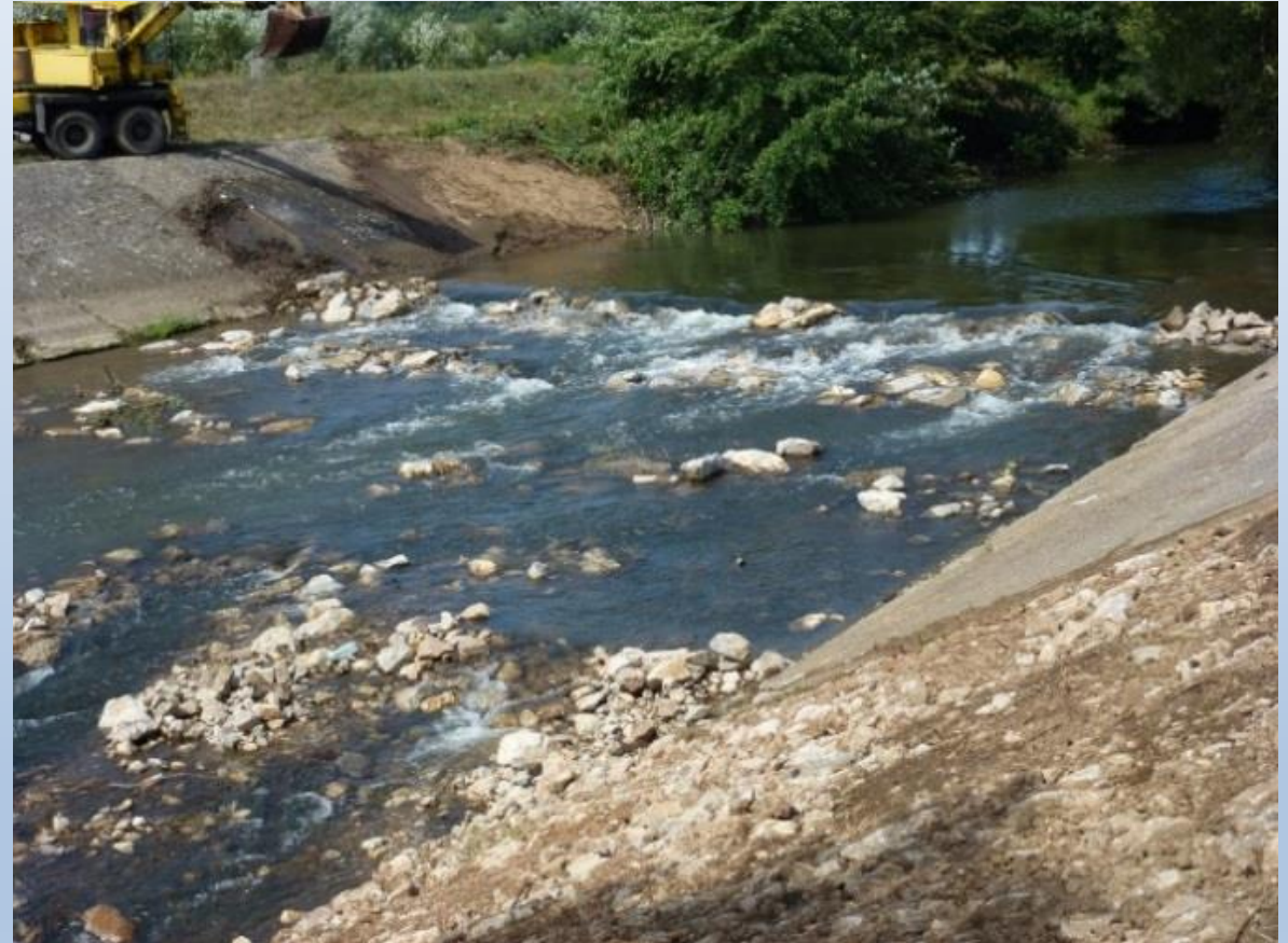
revitalizovaný stupeň – celokorytový bystrinný sklz
