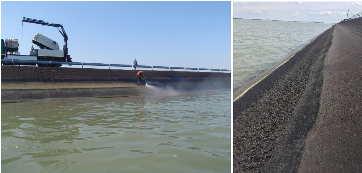
Obrázky: Príprava asfaltobetónového povrchu.
