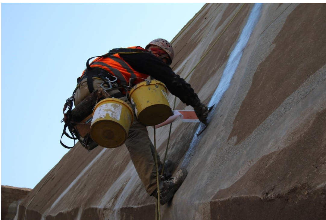
Obrázok č. 12 Zabudovanie výstužného ochranného pásu do trvaloelastickej stierky.
