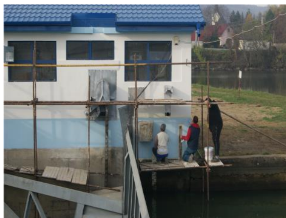
Obr. 6 - Oprava segmentov vyrovnávacej nádrže Malá Domaša
