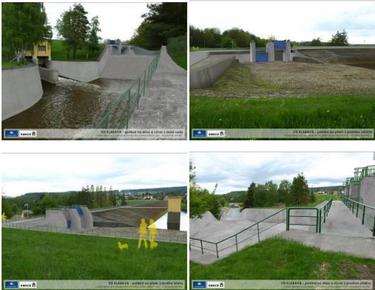
obr. 1 až obr. 4: vizualizace úprav na bezpečnostním přelivu
