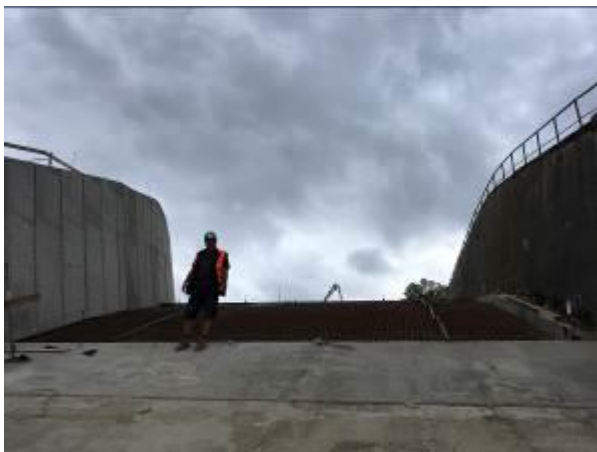
foto. 22 a foto 23: výztuž železobetonové desky dna skluzu před betonáží
