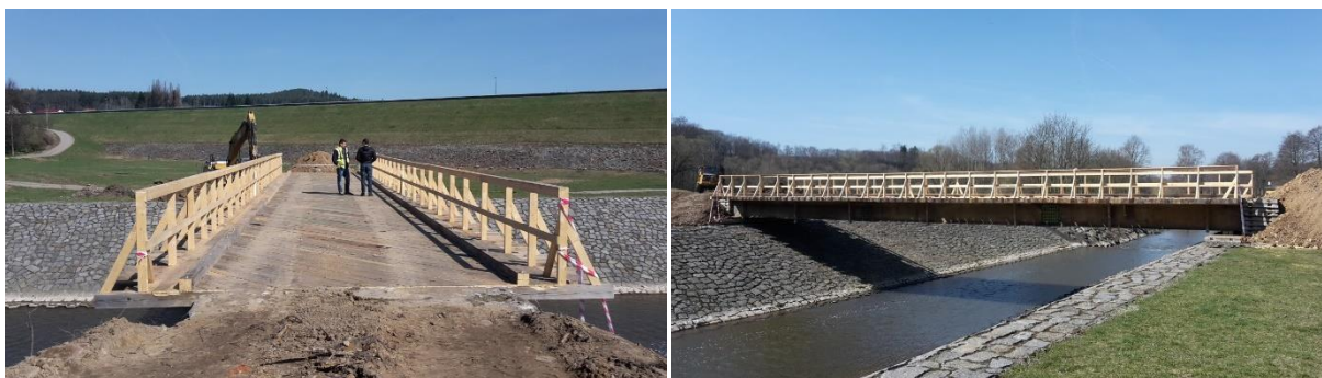
foto. 8 a foto 9: příprava staveniště – provizorní přemostění
