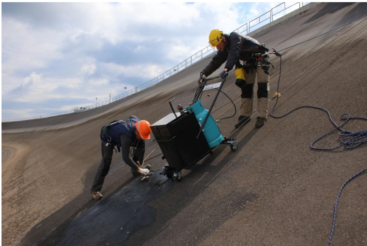
Obrázok č. 9 Roztíranie modifikovaného asfaltu v mieste opravenej vydutiny na šikmej časti hornej nádrže.
