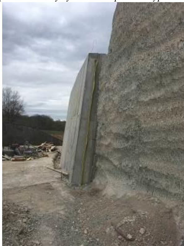
foto. 18 a foto 19: kotvená přibetonávka na rekonstruované pravé zdi skluzu přelivu
