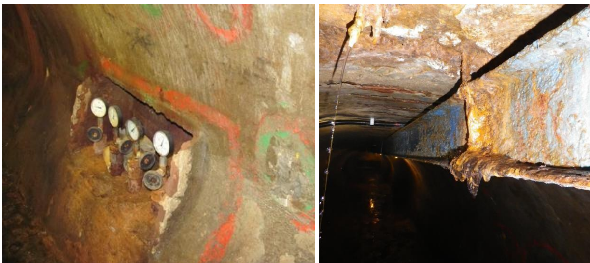
Obr.: Stav manometrického měření a jeřábové dráhy v odpadní štolě před rekonstrukcí.
