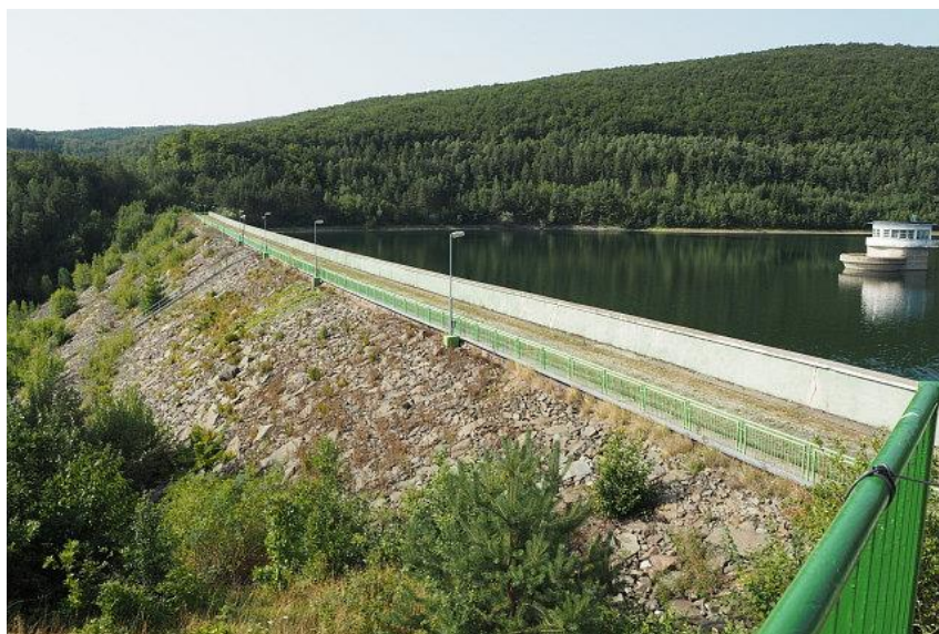
Obr.6 Vodárenská nádrž Bukovec I.
