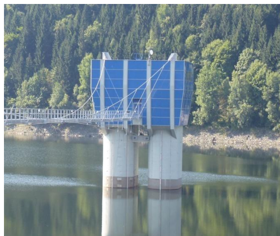
Obr.15 Nové opláštění strojovny
