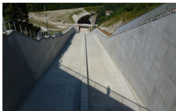
Obr.5 Nová konstrukce skluzu
