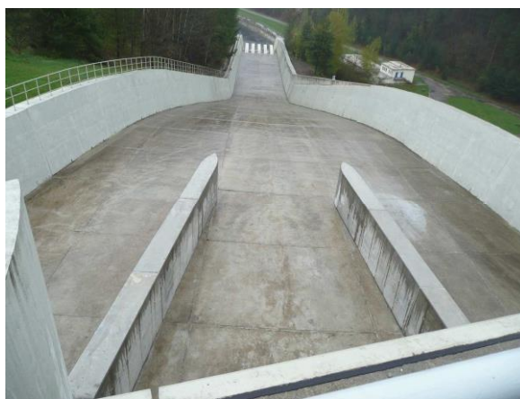
19, 20) VD Římov – – zvýšení bezpečnosti, úpravy bezpečnostního přelivu a skluzu, model a realizace 2008
