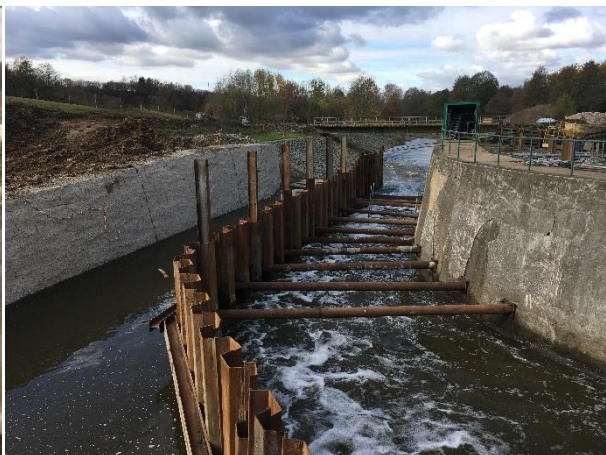
foto. 16 a foto 17: realizace jímky pro možnost převádění vody vývarem od spodních vypustí
