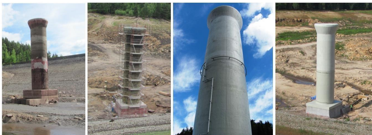
Obr.: Průběh rekonstrukce vnějšího povrchu šachtového přelivu.
