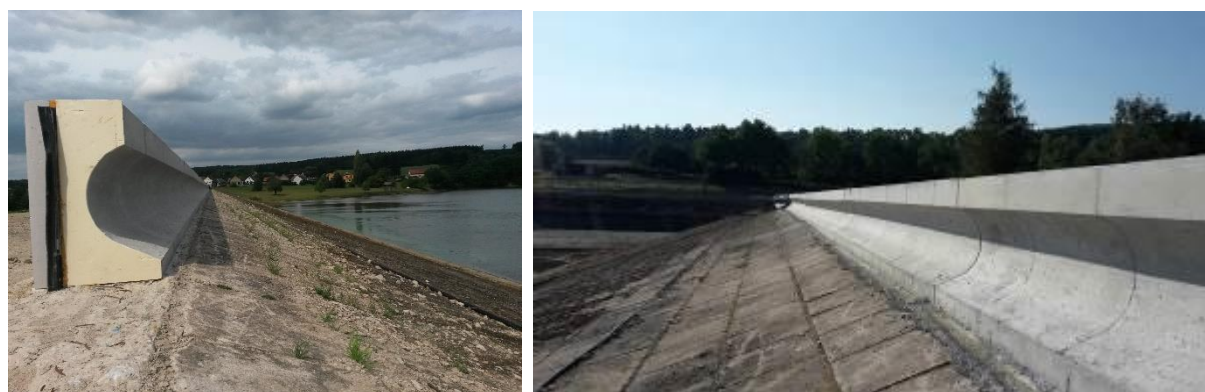
foto. 10 až foto 13: bourací práce původní přelivné plochy a betonových konstrukcí (pro omezení nežádoucích jevů realizováno frézováním)
