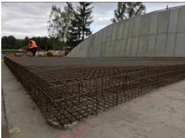
foto. 22 a foto 23: výztuž železobetonové desky dna skluzu před betonáží
