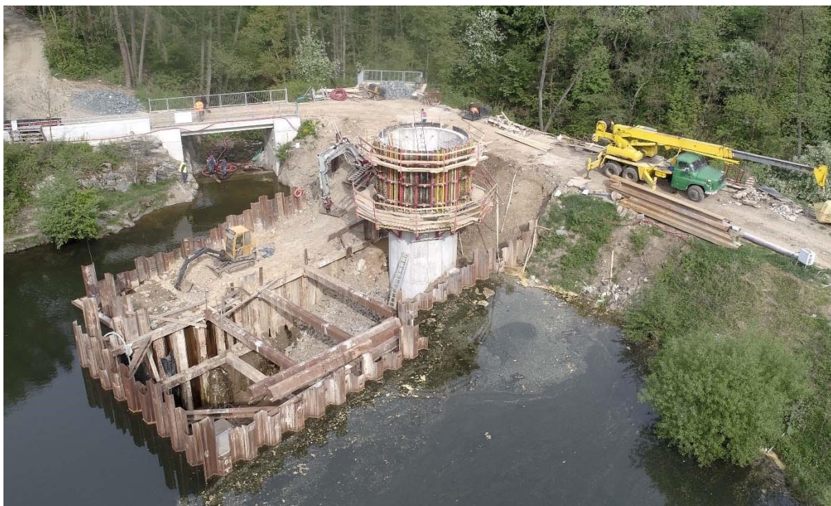
Obr. 4 – Jímka objektu spodní výpusti realizovaná zhotovitelem stavby.
