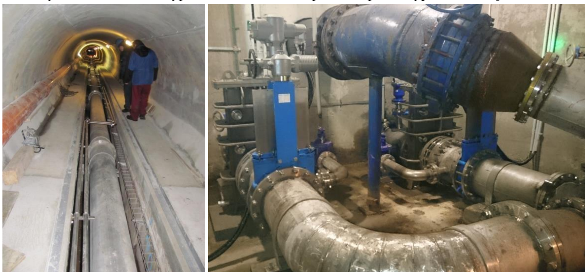
Obr.: Nové potrubí spodní výpusti v odpadní štole a ve strojovně včetně nových uzávěrů.
