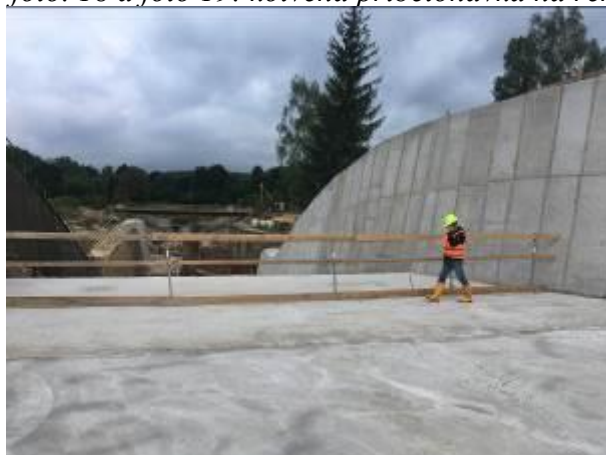
foto. 20 a foto 21: podkladní beton pod betonovou desku skluzu od přelivu chránící před škodami při případném převádění povodní za stavby, do něj kotvy pro vyvázání výztuže samotné železobetonové desky skluzu
