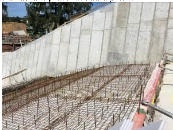
foto. 20 a foto 21: podkladní beton pod betonovou desku skluzu od přelivu chránící před škodami při případném převádění povodní za stavby, do něj kotvy pro vyvázání výztuže samotné železobetonové desky skluzu
