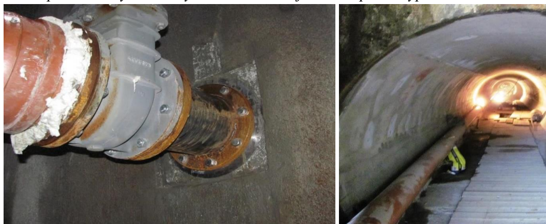
Obr.: Provizorní převod vody za stavby: prostup stěnou šachtového přelivu a v odpadní štolě.
