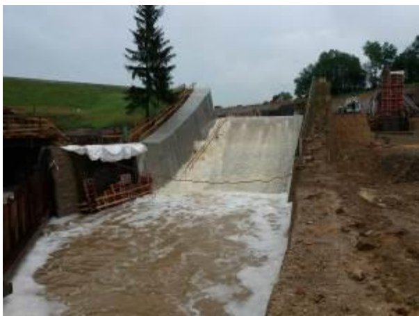
foto. 26 a foto 27: celkový pohled na rekonstrukci skluzu – rozšíření realizací nové levé stěny skluzu při ochraně staveniště původní zdi skluzu, vlevo převádění zvýšených průtoků
