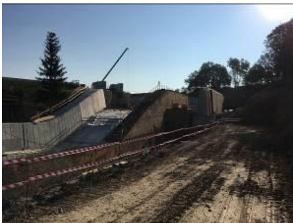
foto. 26 a foto 27: celkový pohled na rekonstrukci skluzu – rozšíření realizací nové levé stěny skluzu při ochraně staveniště původní zdi skluzu, vlevo převádění zvýšených průtoků
