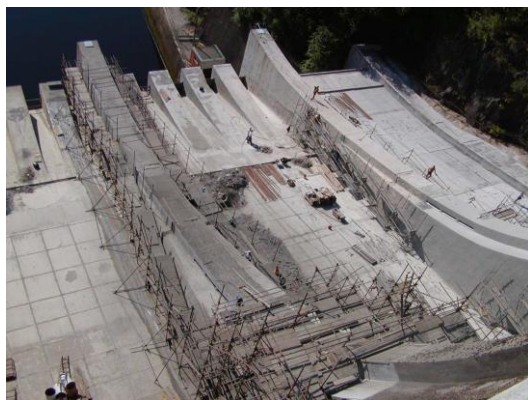
11,12) VD Slapy, sanace přelivů a těsnění v roce 2003
