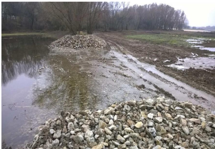
Obr. 10 VN Kunov – oprava zemnej hrádzky kameňom
