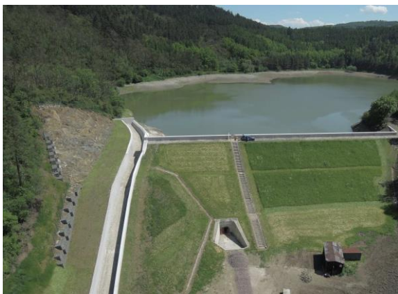
17)VD Suchomasty – zvýšení bezpečnosti, rozšíření bezpečnostního skluzu o bermu 2014 18)VD Klabava – zvýšení bezpečnosti, rozšíření bezpečnostního přelivu a skluzu 2018
