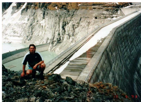
16) Grande-Dixence –nová i původní přehradní hráz 1998
