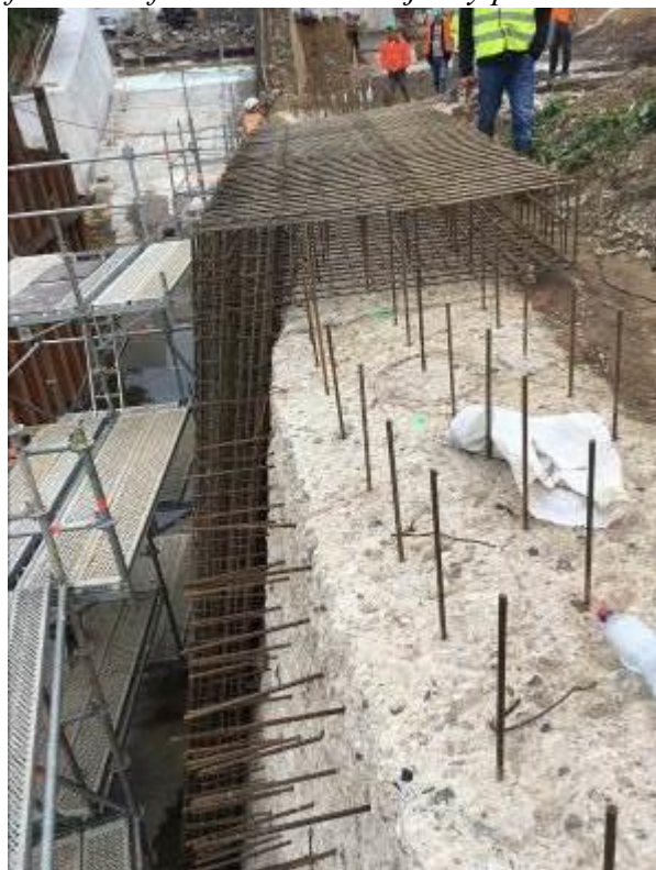
foto. 18 a foto 19: kotvená přibetonávka na rekonstruované pravé zdi skluzu přelivu
