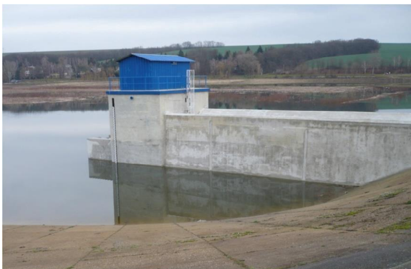
Obr. 7 VN Kunov – prístrešok na funkčnom objekte
