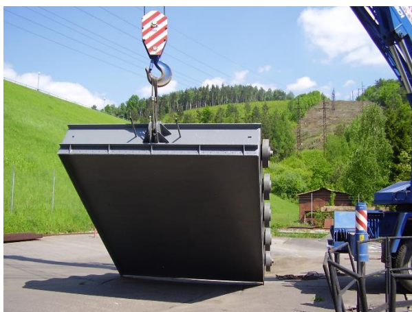
Obr. 4 – Oprava rýchchlouzáveru dnovej výpuste a rozstrekovacieho ventilu
