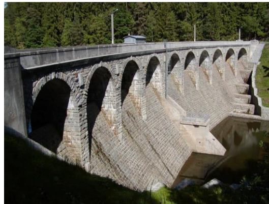
14) VD Sedlice z roku 1928, zdivo je průběžně spárováno a injektováno
