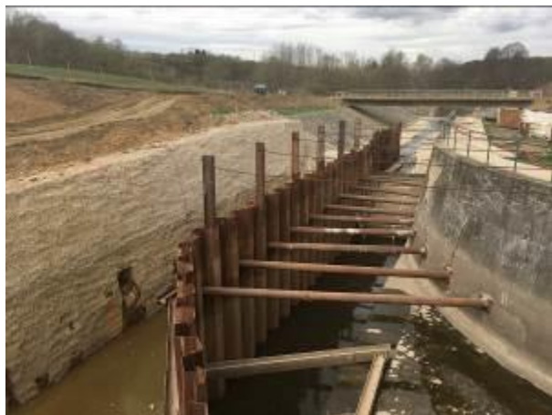
foto. 16 a foto 17: realizace jímky pro možnost převádění vody vývarem od spodních vypustí
