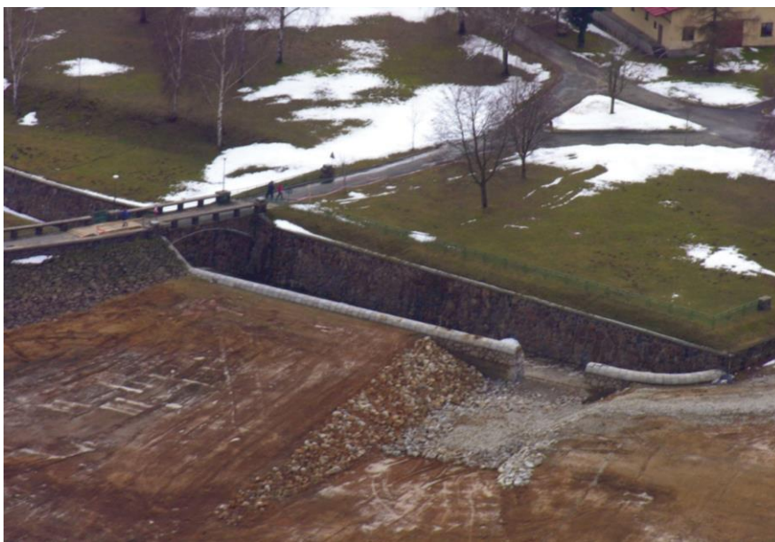
Obr. 4 Otevření přelivu v průběhu rekonstrukce hráze
