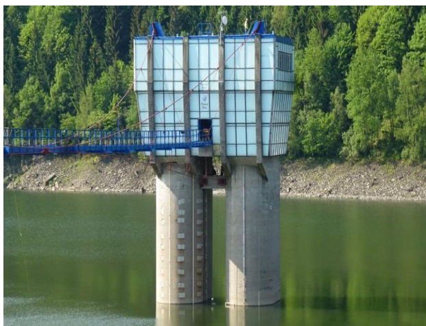
Obr.14 Původní opláštění strojovny
