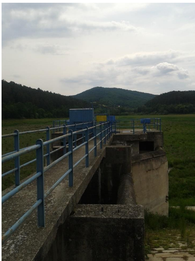
VN Veľké Uherce pred rekonštrukciou
