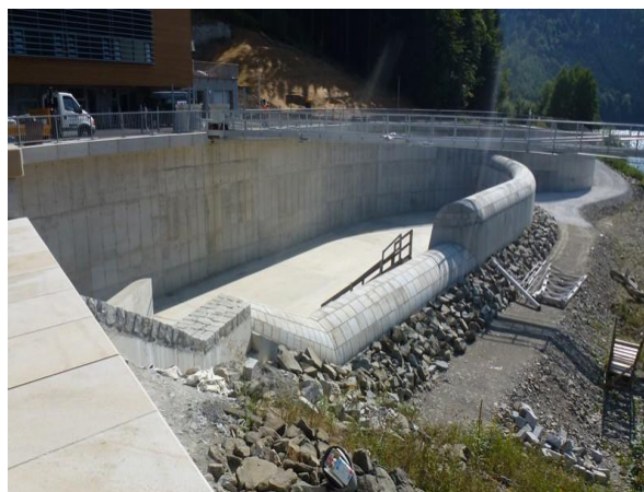
Obr.3 Nová konstrukce přelivu
