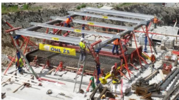
Obr.6 Zařízení pro betonáž dna skluzu
