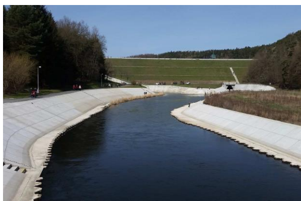
13) VD Hracholusky, oprava opevnění odpadního koryta
