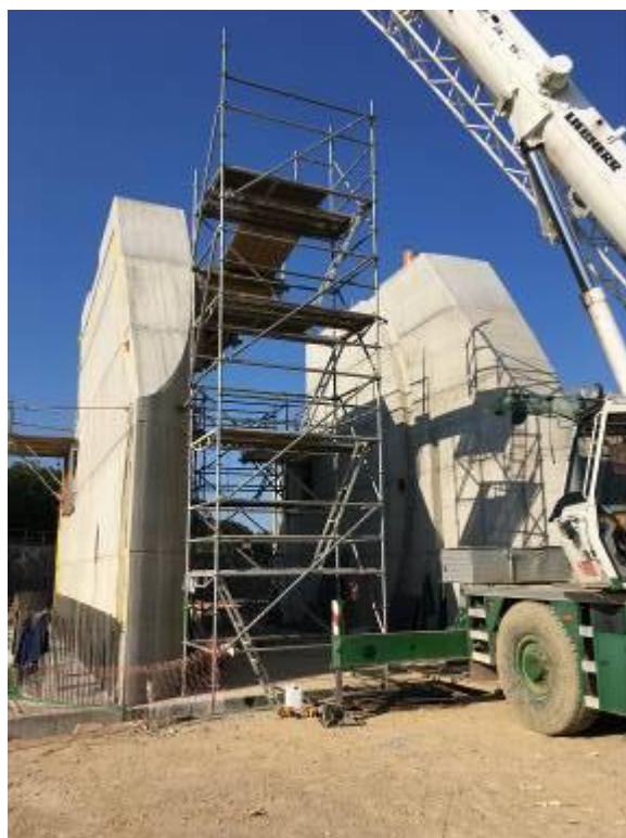
foto. 30 až foto 33: objekt nového přelivu – pilíře dvou segmentových polí
