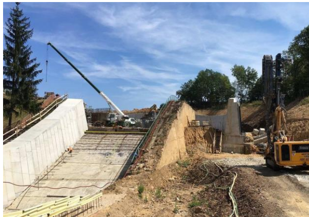
17)VD Suchomasty – zvýšení bezpečnosti, rozšíření bezpečnostního skluzu o bermu 2014 18)VD Klabava – zvýšení bezpečnosti, rozšíření bezpečnostního přelivu a skluzu 2018
