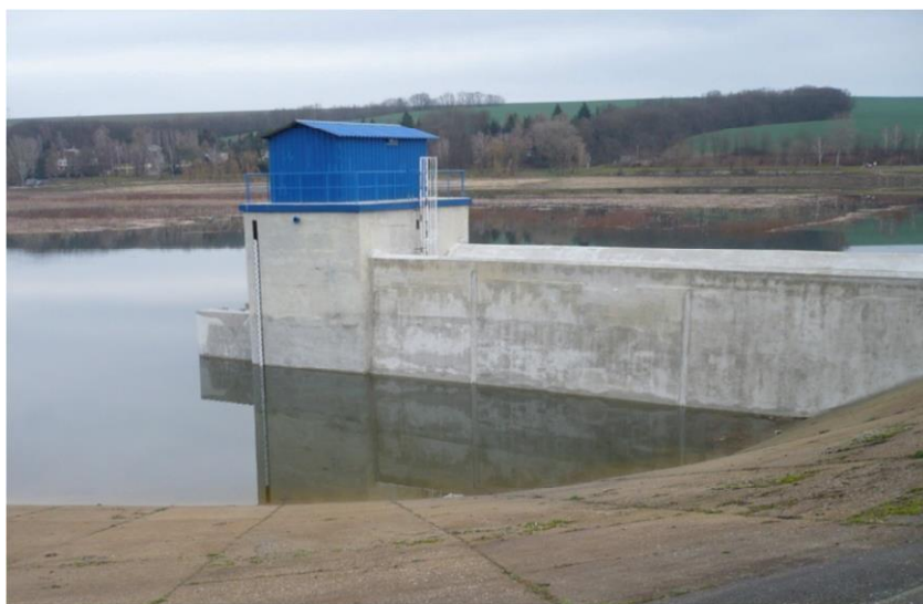
Obr. 7 VN Kunov – prístrešok na funkčnom objekte
