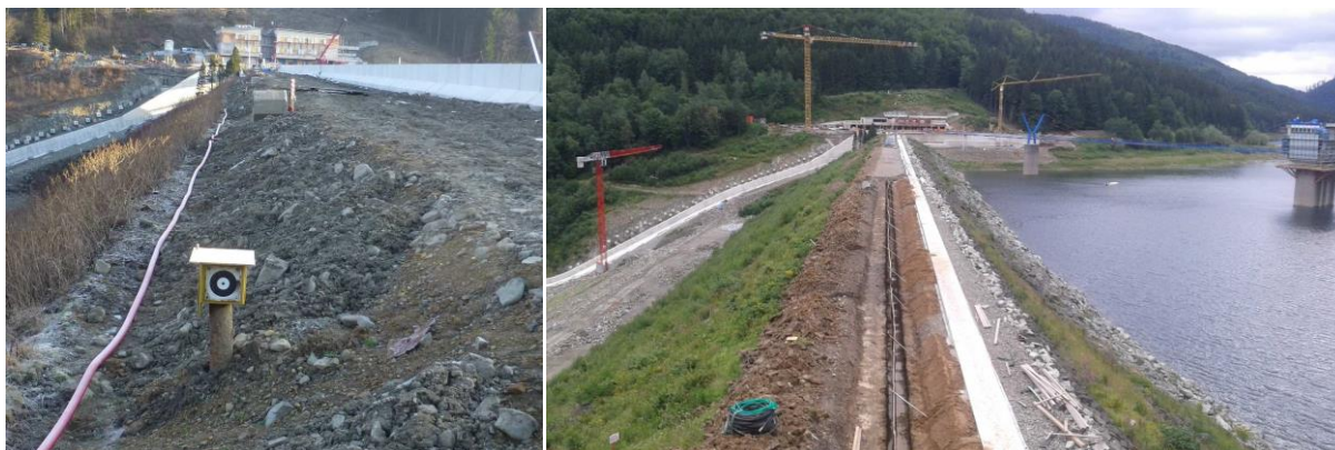
Obrázek 6: Pohled na kontrolní bod, pohled na korunu hráze při ukládání těsnící fólie
