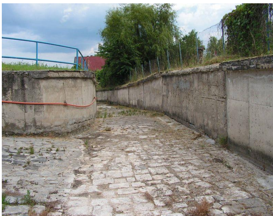
Obr. 6 Kritický prechod od bezpečnostného priepadu do sklzu po povodni 2010
