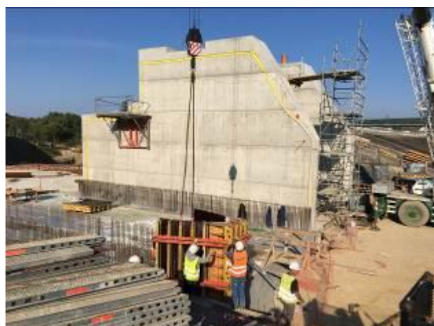
foto. 30 až foto 33: objekt nového přelivu – pilíře dvou segmentových polí
