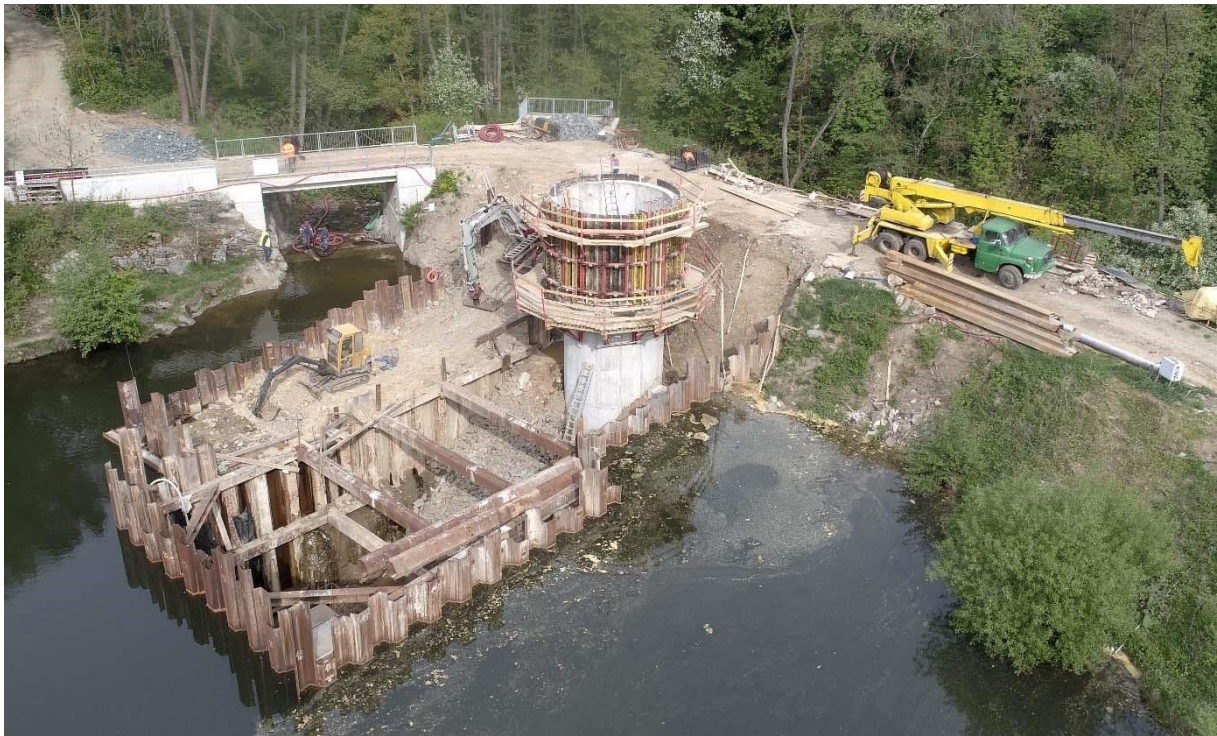
Obr. 4 – Jímka objektu spodní výpusti realizovaná zhotovitelem stavby.
