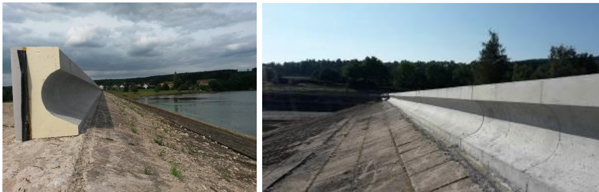
foto. 14 a foto 15: realizace nového vlnolamu na koruně hráze
