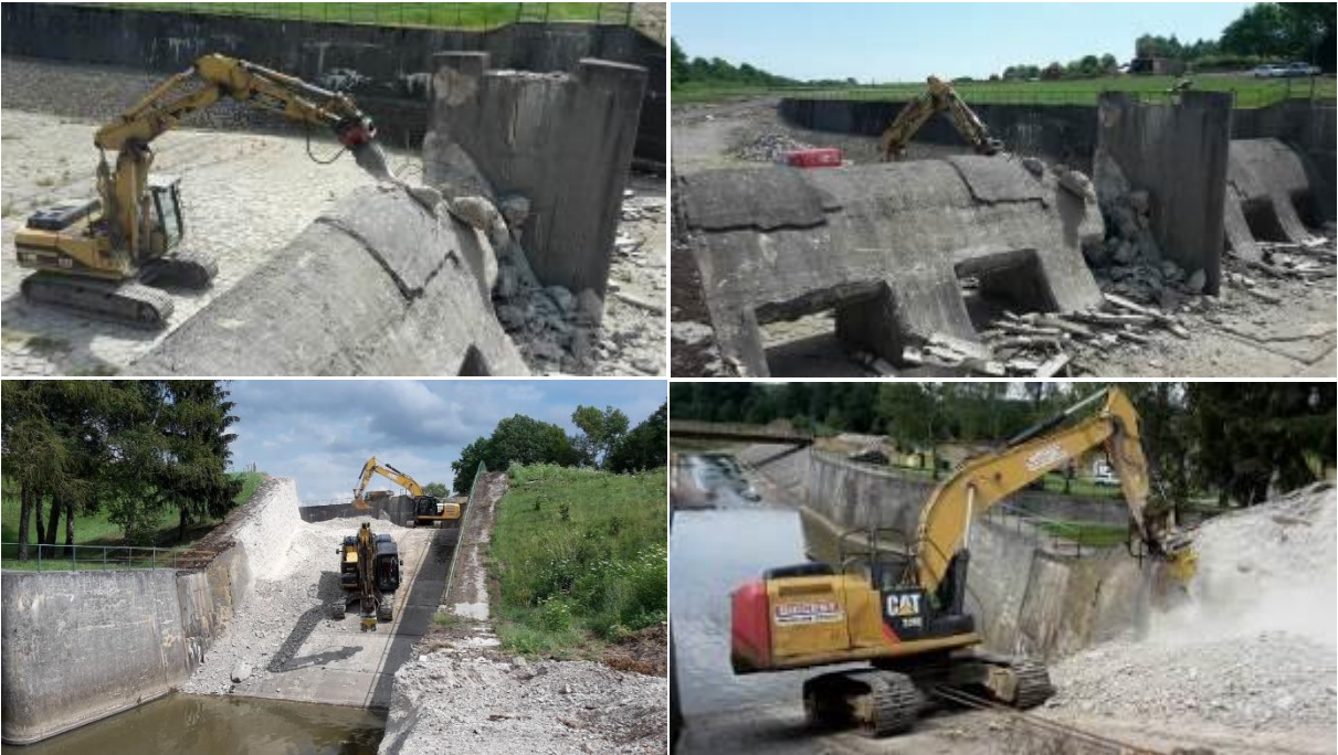
foto. 10 až foto 13: bourací práce původní přelivné plochy a betonových konstrukcí (pro omezení nežádoucích jevů realizováno frézováním)
