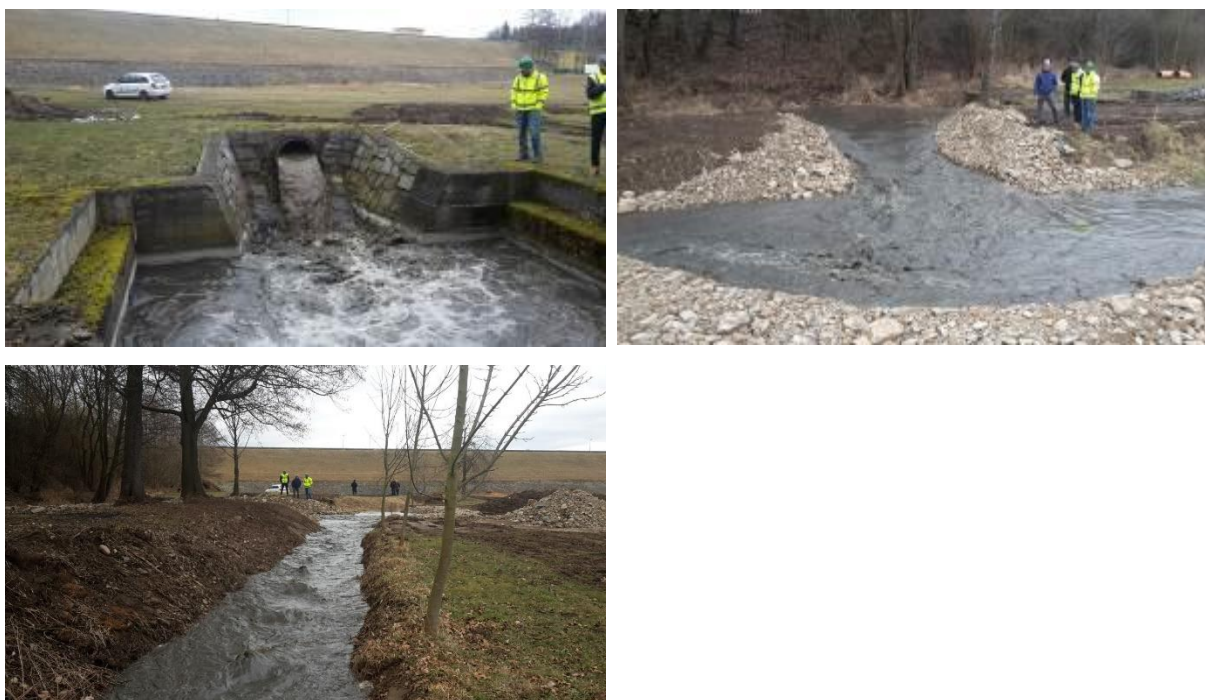
foto 5 až foto 7: realizace obtoku pro převedení vody mimo vývar bezpečnostního přelivu
