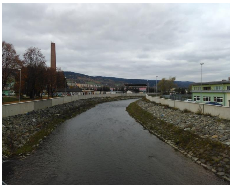
Obr. 3: Realizované betónové protipovodňové steny na rieke Topľa v centrálnej časti mesta Bardejov (Etapa I.) [8, 9]
