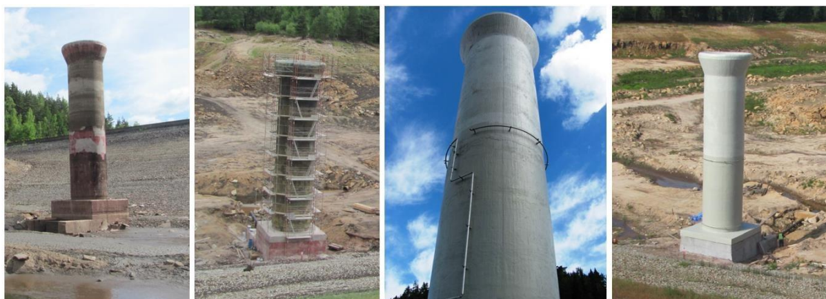
Obr.: Průběh rekonstrukce vnějšího povrchu šachtového přelivu.
