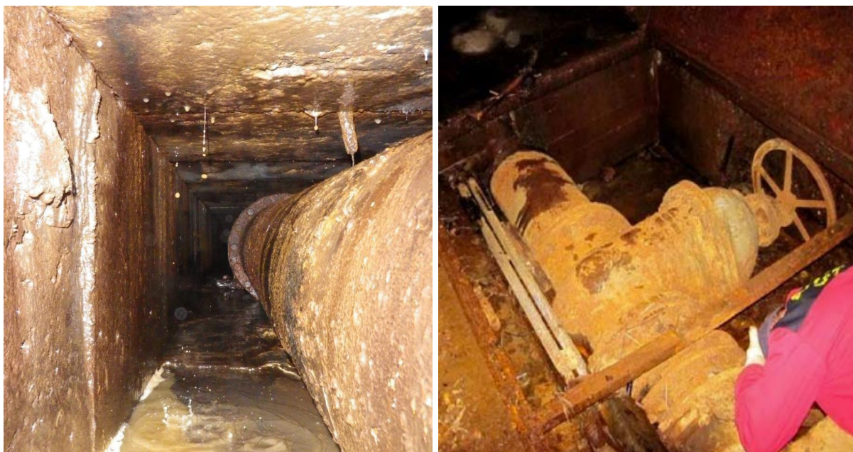
Obr.: Stav potrubí spodní výpusti a návodního uzávěru v odpadní štole před rekonstrukcí.
