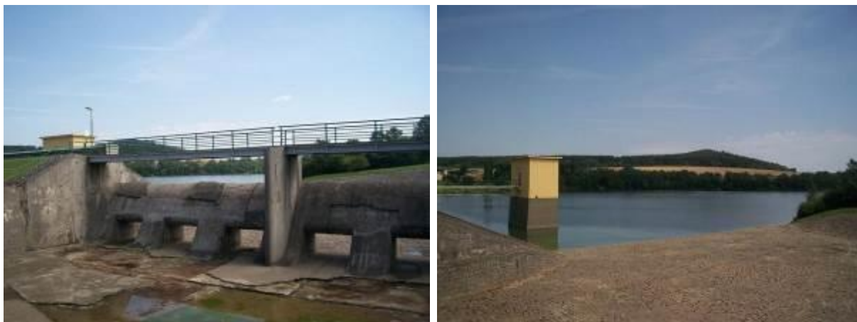
foto 3 a foto 4: bezpečnostní přeliv s okny pro převádění menších povodní
