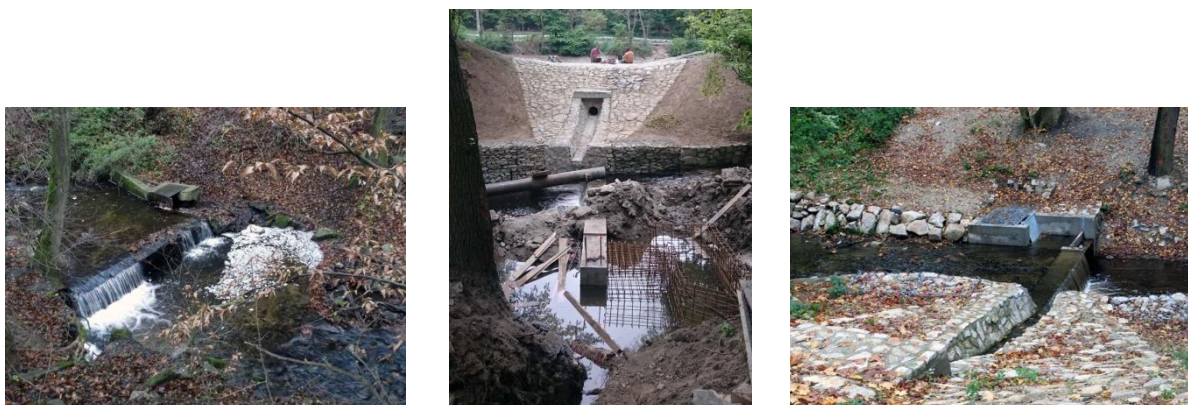
Obr. č. 17, 18, 19 Odberný objekt – pôvodný stav, počas výstavby, nový stav [6]
