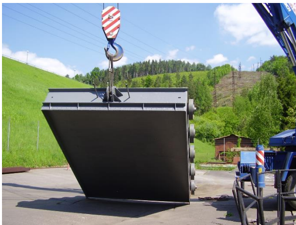
Obr. 4 – Oprava rýchlozáveru dnovej výpuste a rozstrekovacieho ventilu
