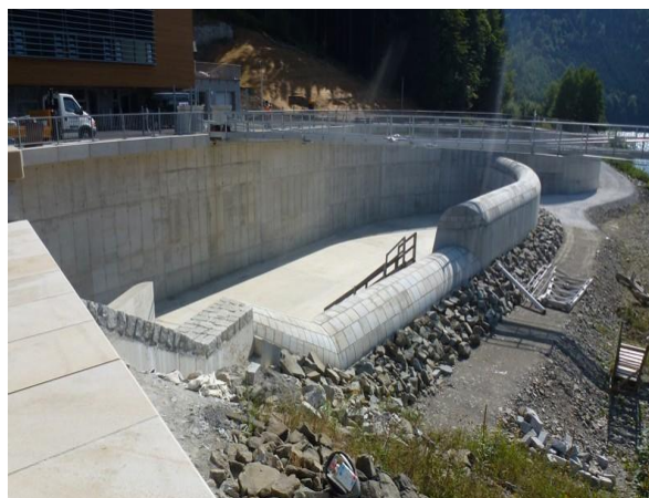
Obr.3 Nová konstrukce přelivu
