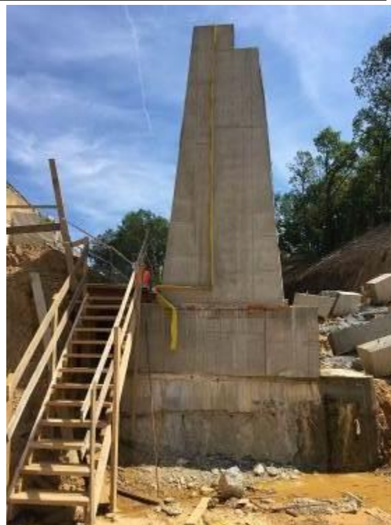
foto. 28 a foto 29: rozšíření skluzu realizací levé zdi skluzu ve svahu. Na levém snímku patrná původní levá zeď skluzu
