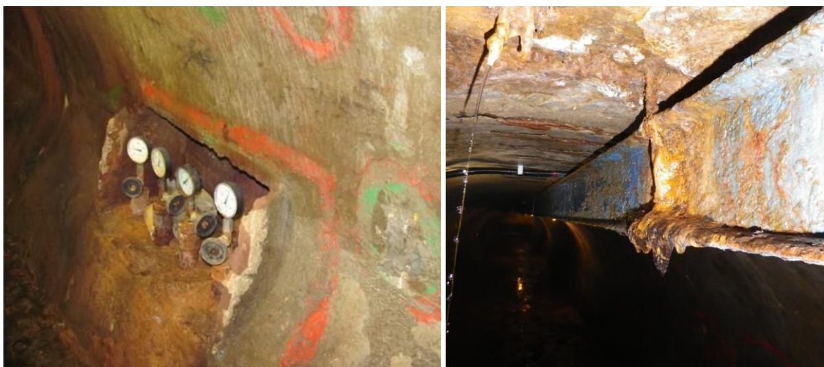
Obr.: Stav manometrického měření a jeřábové dráhy v odpadní štole před rekonstrukcí.
