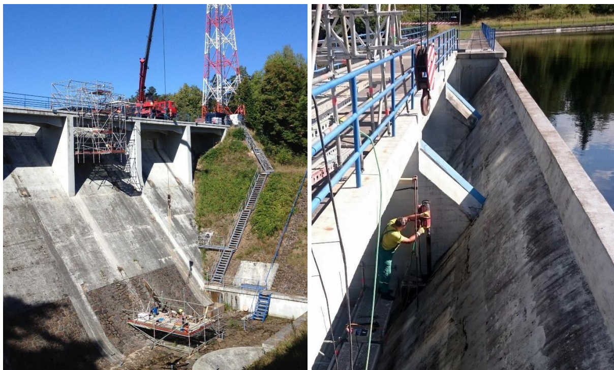
Obr. č. 3, 4 – Celkový pohľad na bezpečnostný preliv hráze, z polohy prístupových plošín je možné získať predstavu o rozmístení obou vzlakomerných vrtů (foto vľavo). Pozícia svislého vrtu VN vyplýva z požiadavky na pohodlné provádzanie merení z mostovky na koruně hráze. To si vynutilo instaláciu komplikovaného lešenia, aby bola zajištená maximálna bezpečnosť provádzaných prác (foto vpravo). Pro obslužné práce byl využíván autojeřáb.
