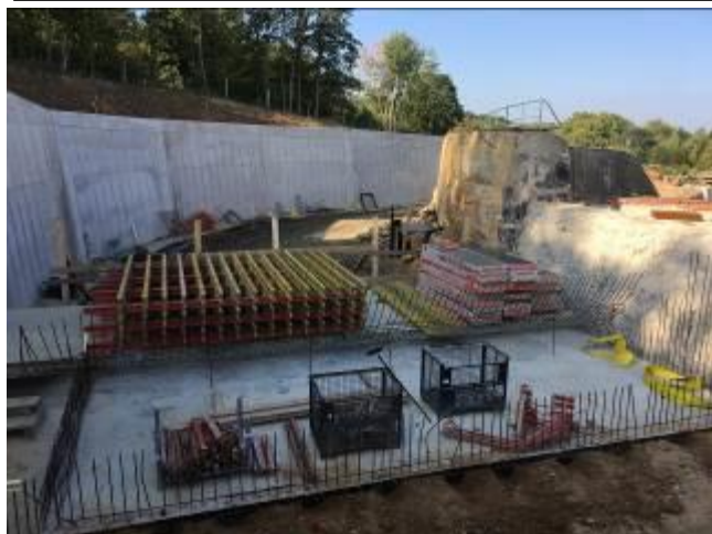
foto. 28 a foto 29: rozšíření skluzu realizací levé zdi skluzu ve svahu. Na levém snímku patrná původní levá zeď skluzu
