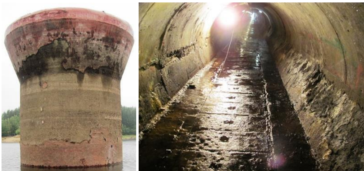
Obr.: Stav šachtového přelivu a odpadní štoly před rekonstrukcí.
