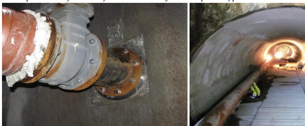
Obr.: Provizorní převod vody za stavby: prostup stěnou šachtového přelivu a v odpadní štole.
