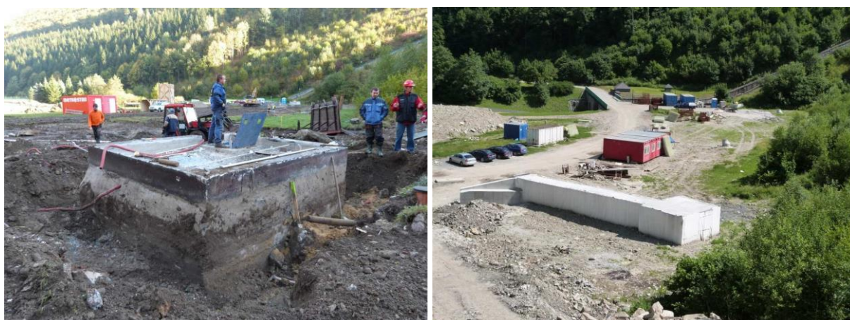
Obrázek 5: Přístupová chodba v podhráží (původní stav, stav před zahájením sypání)
