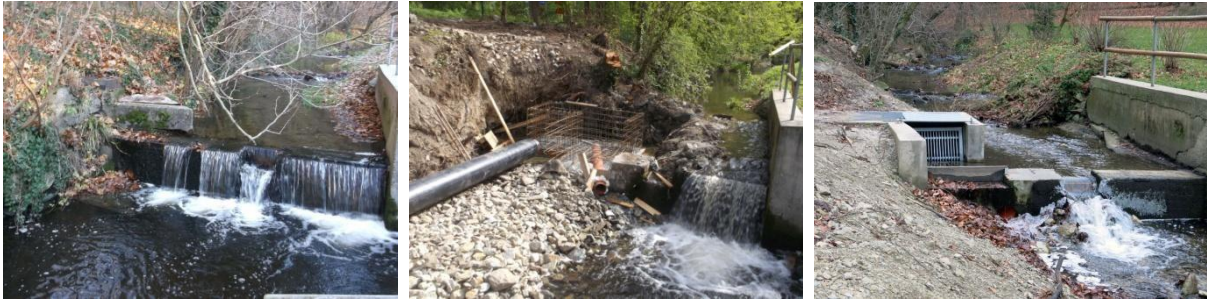
Obr. č.2,3,4 Odberný objekt – pôvodný stav, počas výstavby, nový stav [6]
