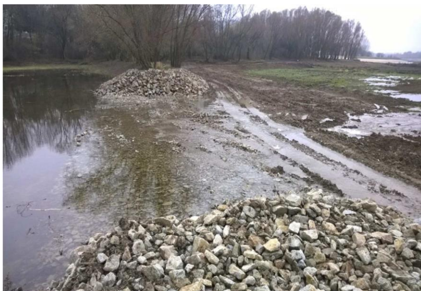
Obr. 10 VN Kunov – oprava zemnej hrádzky kameňom
