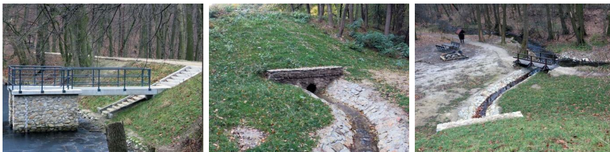
Obr. č.24, 25, 26 Výpustný objekt a odvádzacie koryto na vzdušnej strane hrádze - nový stav [6]
