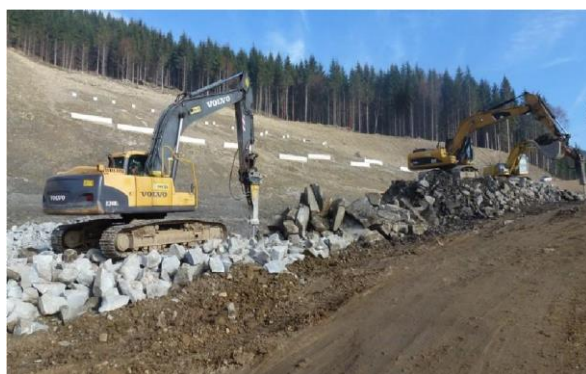
Obr.12 Zajištění sesuvu a příprava materiálu pro stabilizační přísyp hráze
