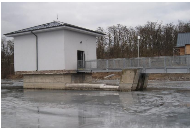
Obr. 2: Foto sdruženého objektu - bezpečnostní přeliv a strojovna spodních výpustí
