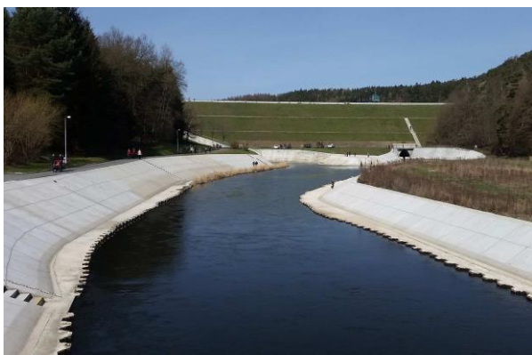
13) VD Hracholusky, oprava opevnění odpadního koryta
