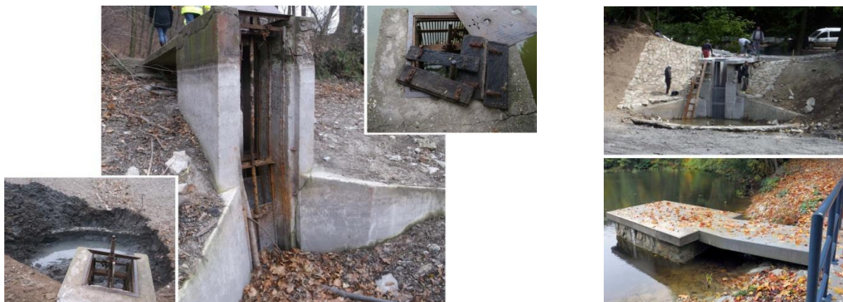
Obr. č.8,9,10 Pôvodný výpustný objekt a odhalené lovisko[6]; Obr. č.11,12 Nový výpustný objekt počas výstavby s pôvodným loviskom a nový stav po napustení nádrže [6]
