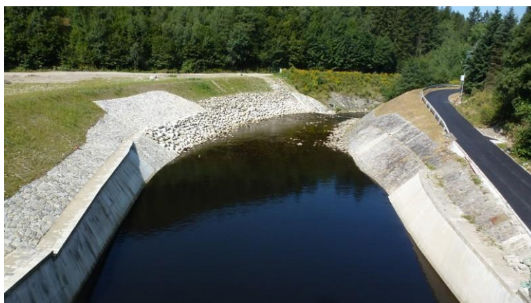
Obr.8 Vývar a odpadní koryto po rekonstrukci
