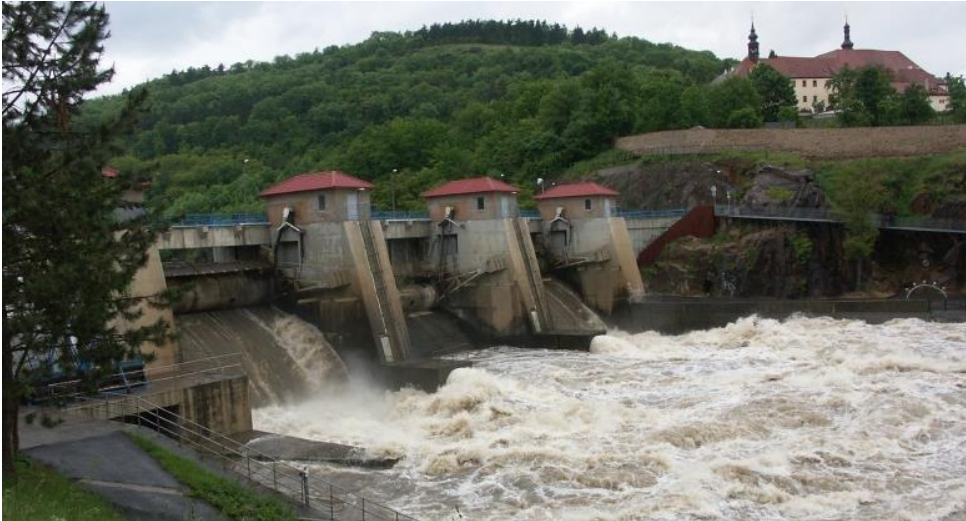
Obr.1: Pohled na vodní dílo Kadaň
