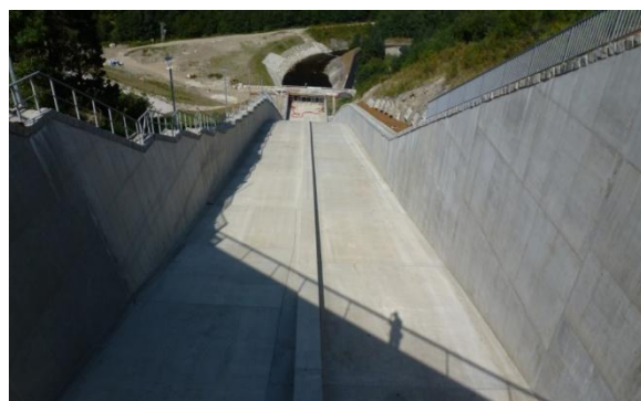
Obr.5 Nová konstrukce skluzu
