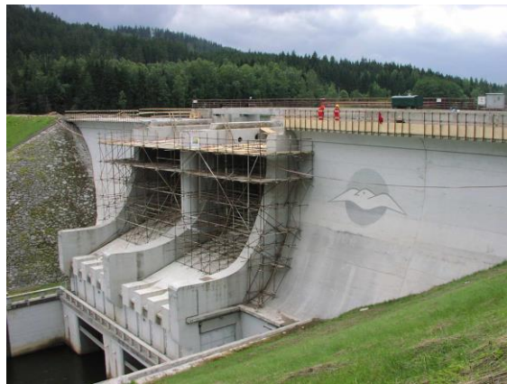
7) VD Husinec, výměna mostovky v roce 2014 po 75 letech provozu 8) VD Lipno, výměna mostovky v roce 2004 po 50 letech provozu
