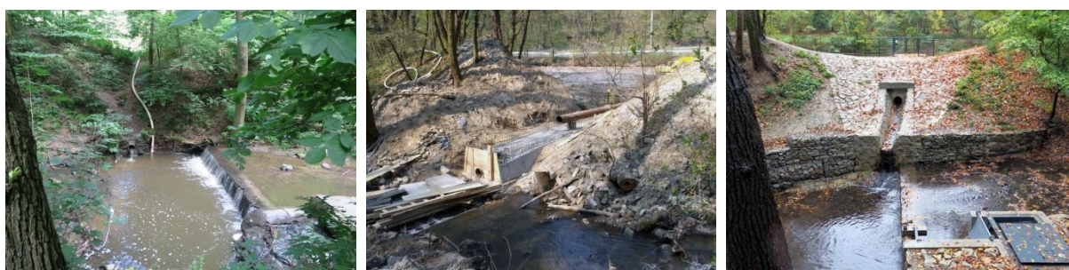
Obr. č.13,14,15 Výpustný objekt –vzdušná strana hrádze - pôvodný stav, počas výstavby, nový stav [6]
