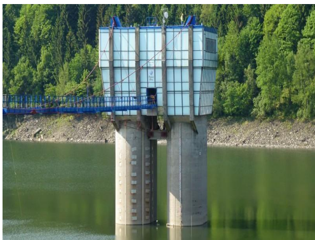
Obr.14 Původní opláštění strojovny
