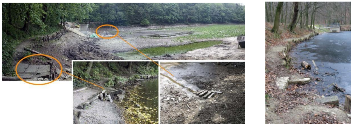
Obr. č.20 Núdzový priepad, dnový výpust a výpustný objekt vo výstavbe – umiestnenie v nádrži; Obr. č. 21 Núdzový priepad - pôvodný stav; Obr. č. 22 Dnový výpust - pôvodný stav; Obr. č. 23 Zamurovaný núdzový priepad v popredí, výpustný objekt s mrežou núdzového priepadu na výmurovke v pozadí – nový stav [6]
