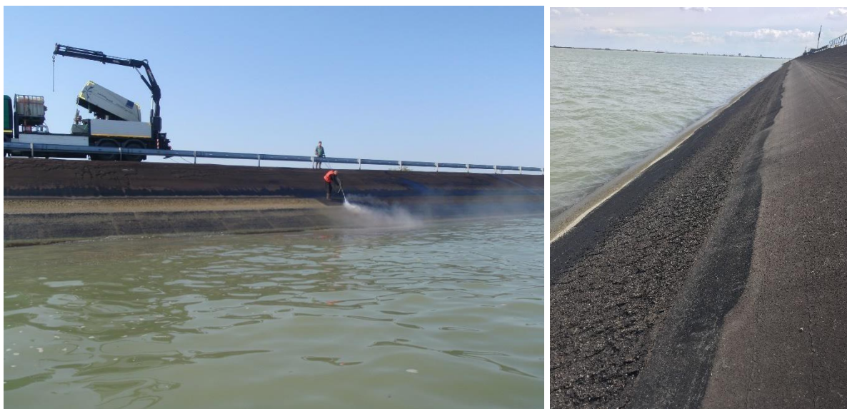
Obrázky: Príprava asfaltobetónového povrchu.
