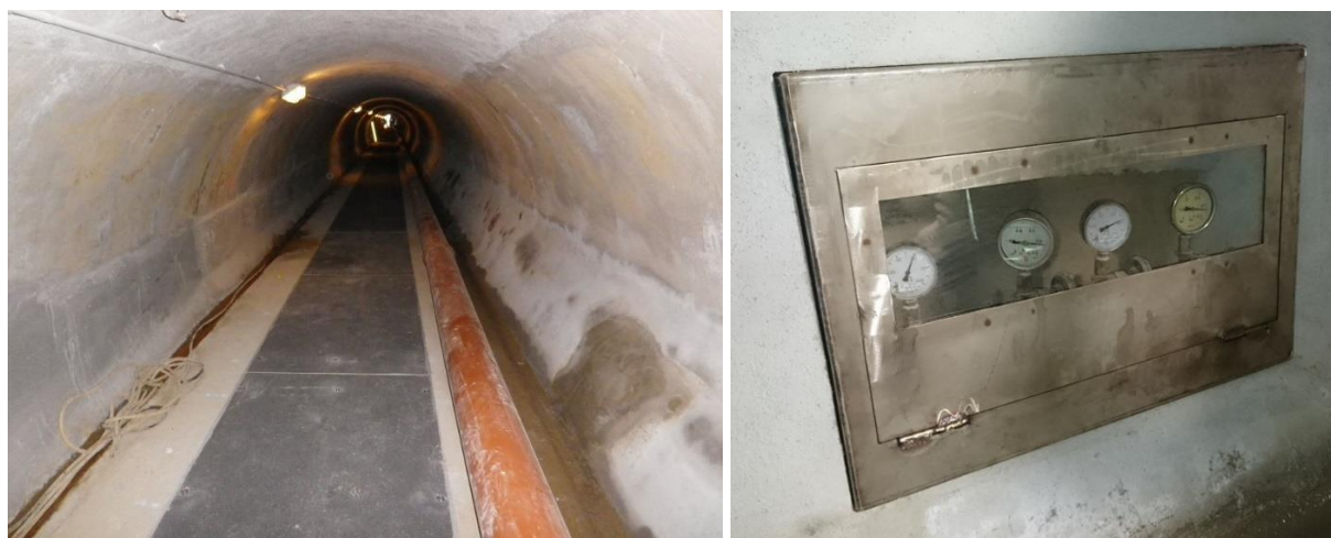
Obr.: Stav odpadní štoly a manometrického měření po rekonstrukci.
