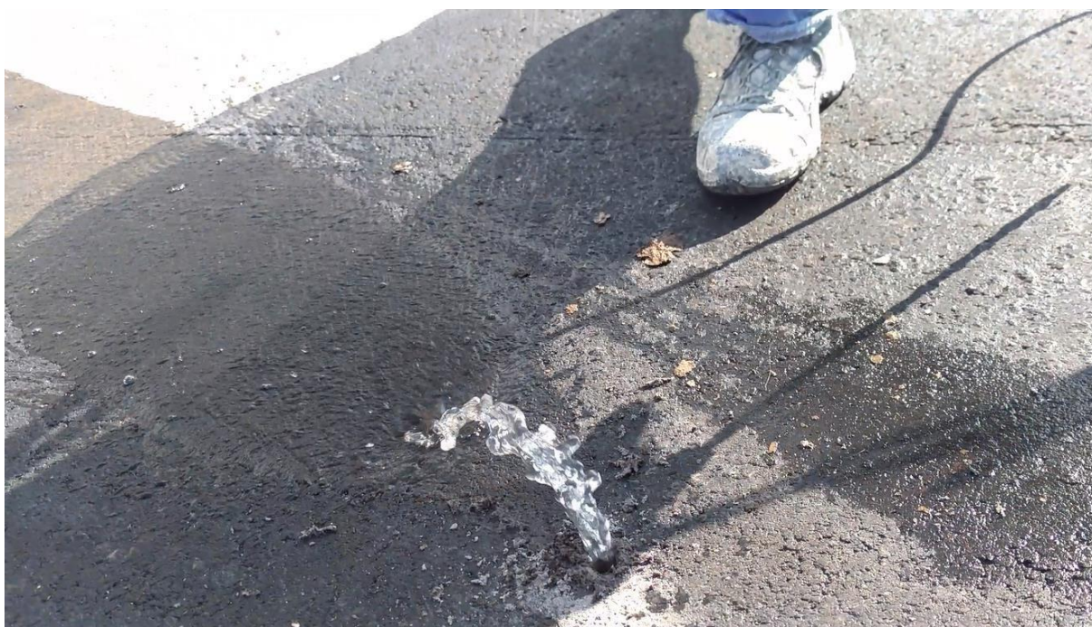
Obrázok č. 8 Výver vody po prevrtaní asfaltobetónového tesnenia na šikmej časti hornej nádrže PVE Čierny Váh.
