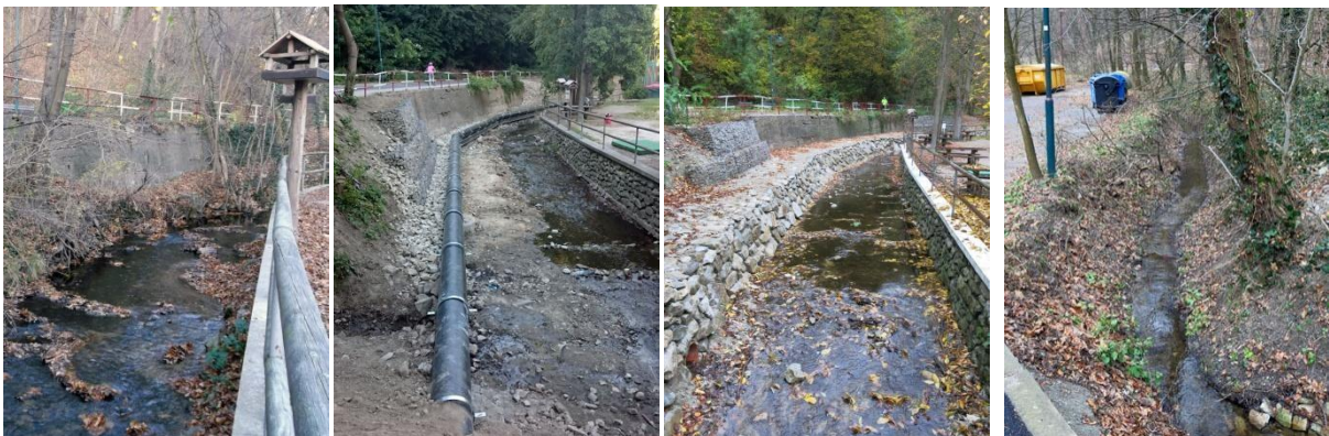
Obr. č.5,6,7 Prívodné potrubie – pôvodný stav terénu, počas výstavby, nový stav[6]; Obr. č.8 Prívodný kanál [6]
