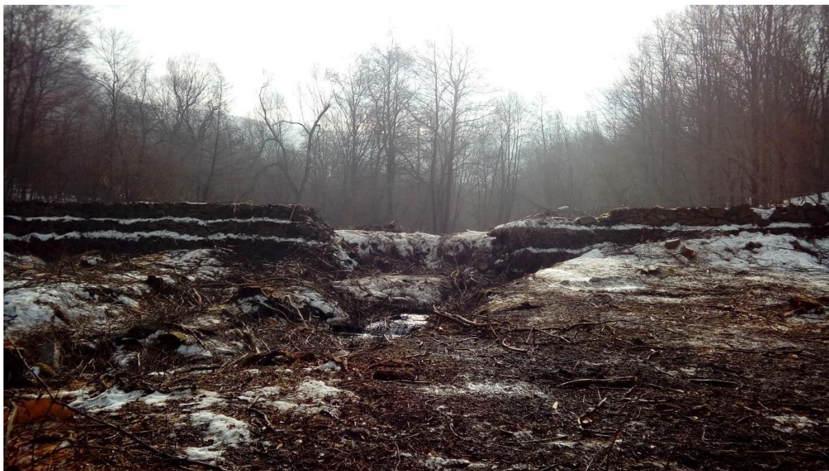
Jestvujúca prehrádzka v Lehote pod Vtáčnikom pred rekonštrukciou
