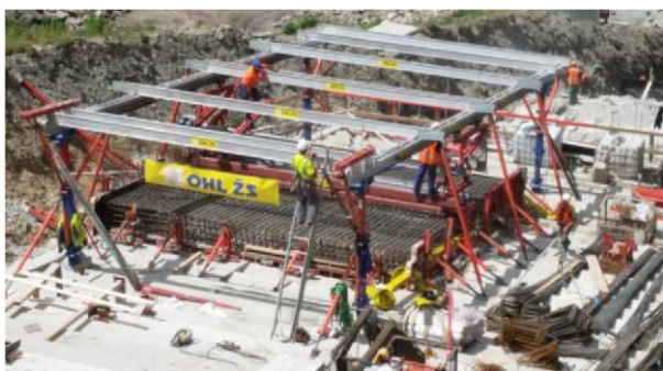
Obr.6 Zařízení pro betonáž dna skluzu
