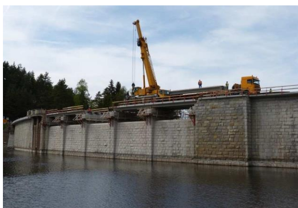
7) VD Husinec, výměna mostovky v roce 2014 po 75 letech provozu 8) VD Lipno, výměna mostovky v roce 2004 po 50 letech provozu
