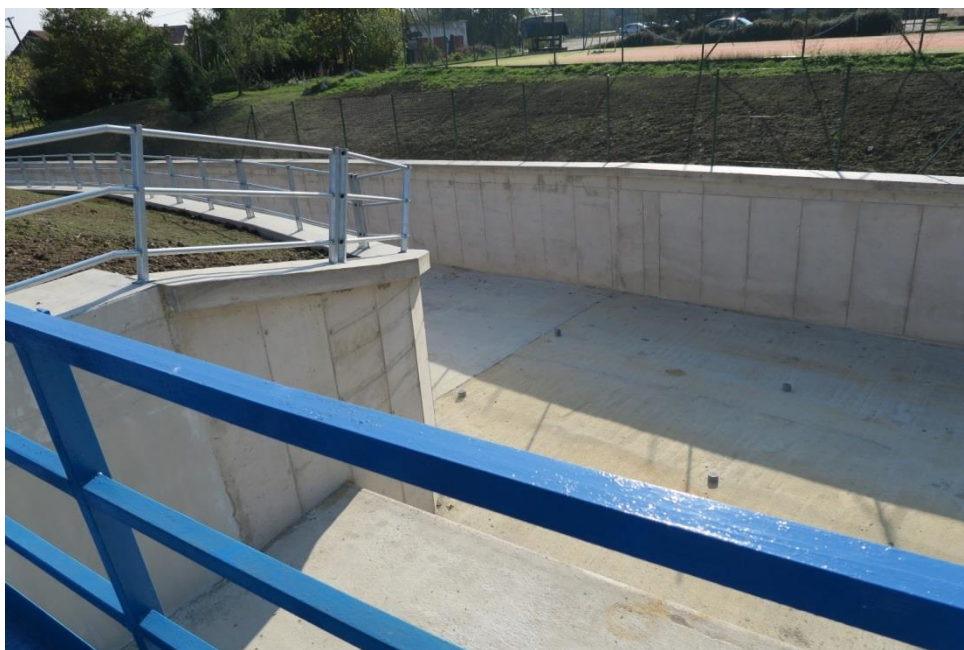
Obr. 8 Pohľad na zrekonštruovaný prechod od BP do sklzu
