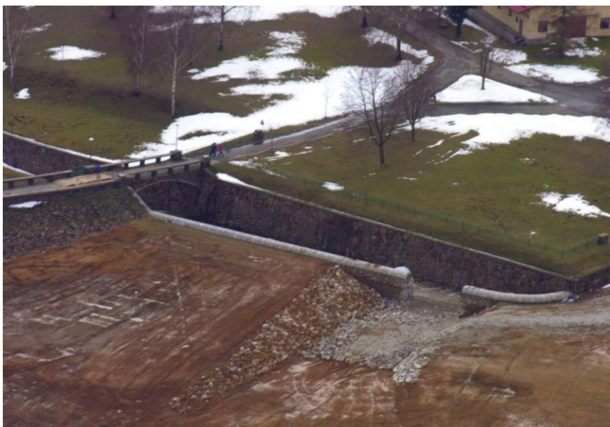
Obr. 4 Otvěření přelivu v průběhu rekonstrukce hráze
