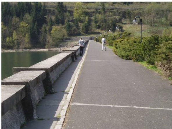
Obr.9 Původní koruna hráze
