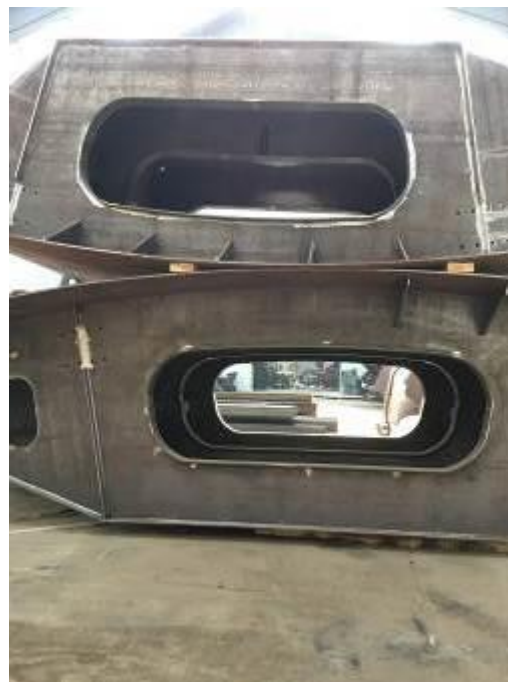
foto 35 a foto 36: výroba ocelové konstrukce segmentů bezpečnostního přelivu
