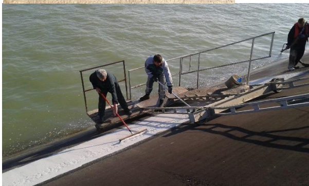
Obrázky: Aplikácia sanačného materiálu
