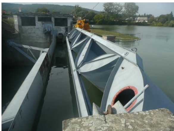
Obr. 6 - Oprava segmentov vyrovnávacej nádrže Malá Domaša
