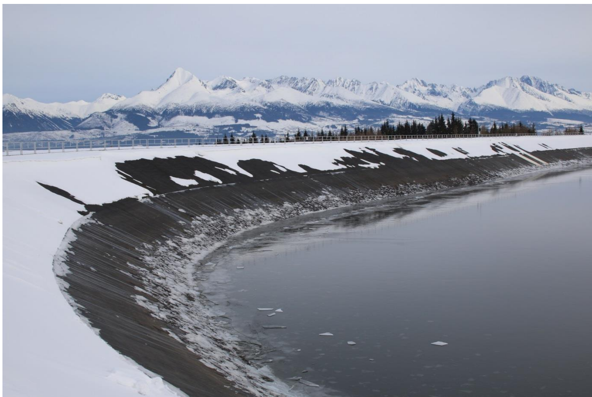
Obrázok č. 3 Lámanie ľadu na návodných svahoch po obvode hornej nádrže.
