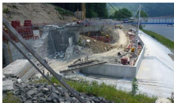
Obr.7 Protipovodňová ochrana staveniště
