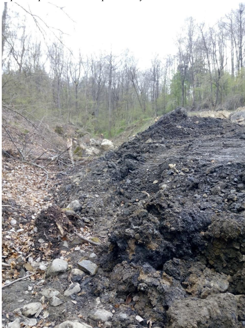
Koryto Račieho potoka pred budovaním prehrádzky
