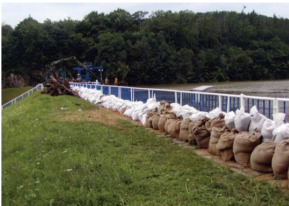
Obr. 6 Pytle s pískem umístěné na koruně hráze VD Znojmo s cílem snížit riziko přelítí
