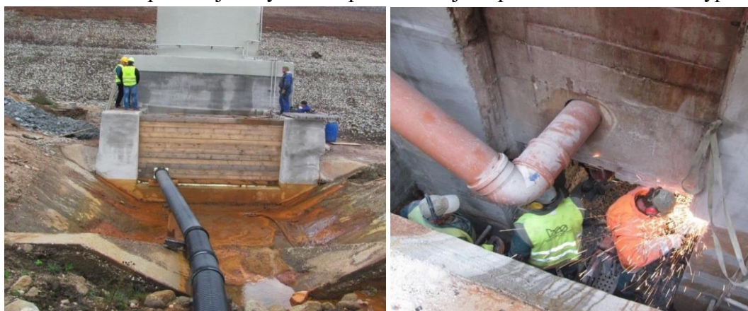
Obr.: Provizorní převod vody za stavby ve vtokovém objektu do spodní výpusti.
