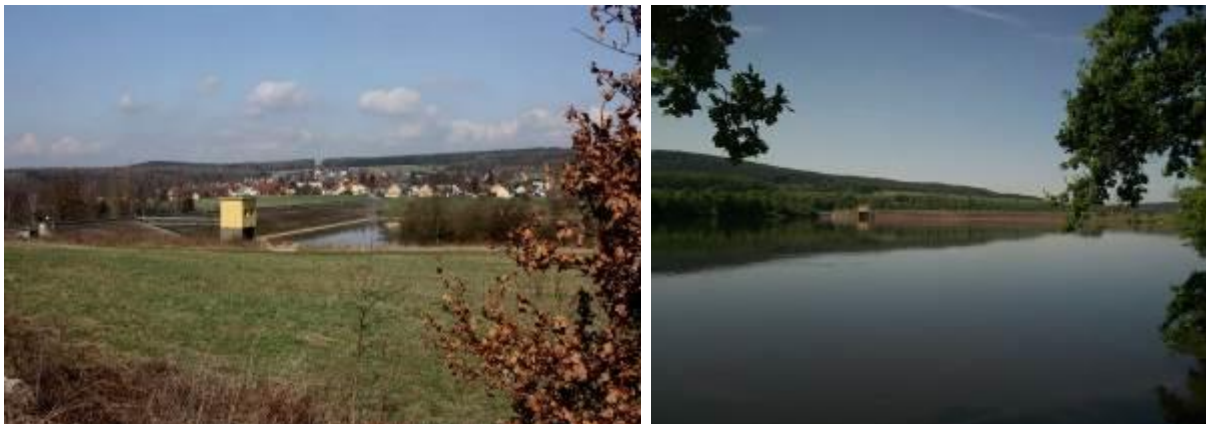
foto 1: celkový pohled na hráz z levého břehu
