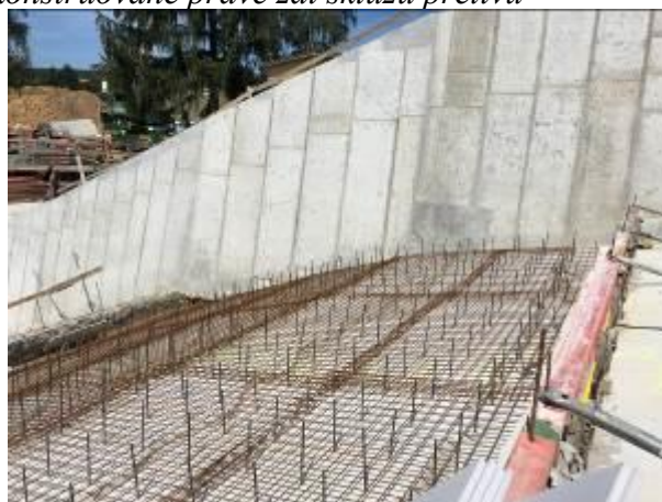
foto. 20 a foto 21: podkladní beton pod betonovou desku skluzu od přelivu chránící před škodami při případném převádění povodní za stavby, do něj kotvy pro vyvážení výztuže samotné železobetonové desky skluzu
