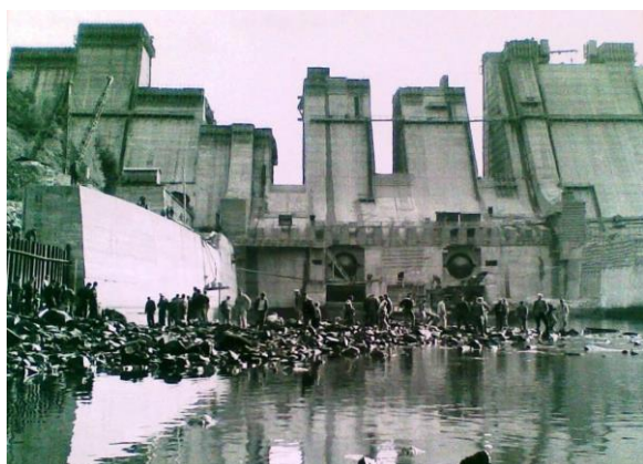
5) Stavba VD Orlik na Vltavě, 1954-63
