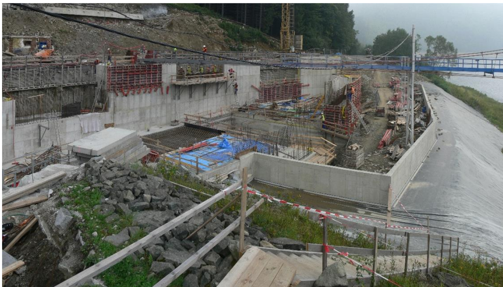
Obr. 5 Betonová jímka aplikovaná při rekonstrukci VD Šance
