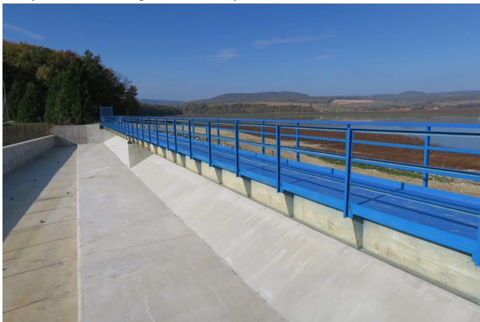
Obr. 7 Pohľad na bezpečnostný priepad a zátopu nádrže od sklzu
