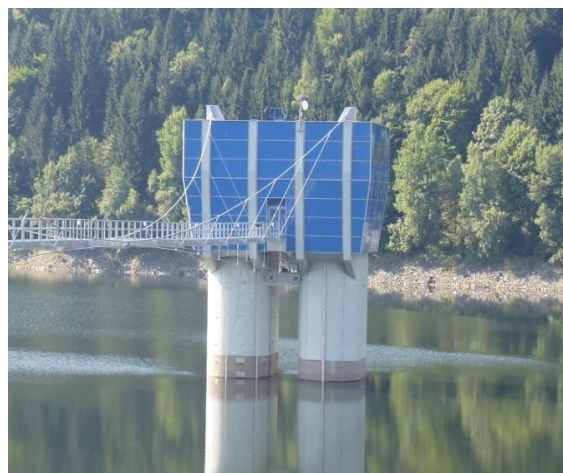
Obr.15 Nové opláštění strojovny
