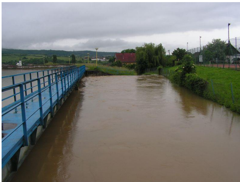
Obr. 5 Zaplnený bezpečnostný priepad 4.6.2010 pri hladine 221,25 m n. m.
