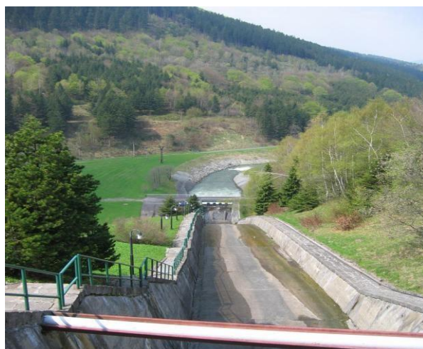
Obr.4 Původní konstrukce skluzu
