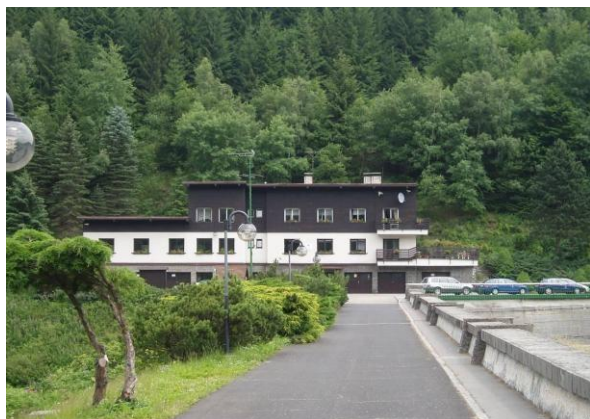
Obr. 16 Původní provozní budova
