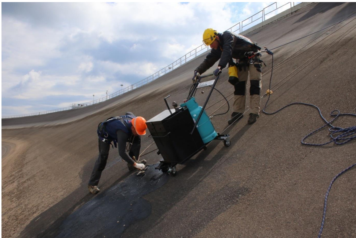
Obrázok č. 9 Rozotieranie modifikovaného asfaltu v mieste opravenej výdutiny na šikmej časti hornej nádrže.
