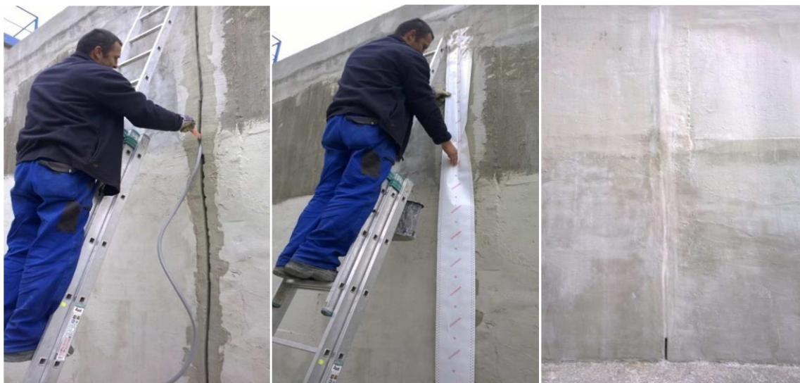
Obr. 4 a, Vtláčanie ochranného povrazca do DŠ na vnútornej strane BP b, Lepenie a tvarovanie „Omega“ tesniacej pásky DICHTBAND 2000 c, Opravená dilatačná škára vo vnútri bezpečnostného priepadu Zdroj: SVP š.p., Správa povodia Moravy
