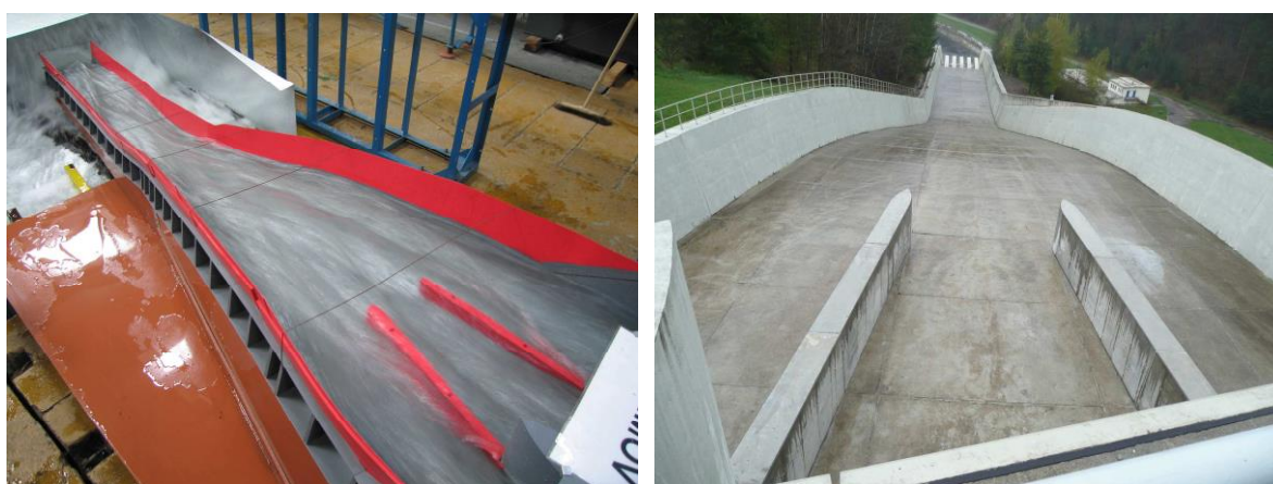
19, 20) VD Římov - - zvýšení bezpečnosti, úpravy bezpečnostního přelivu a skluzu, model a realizace 2008
