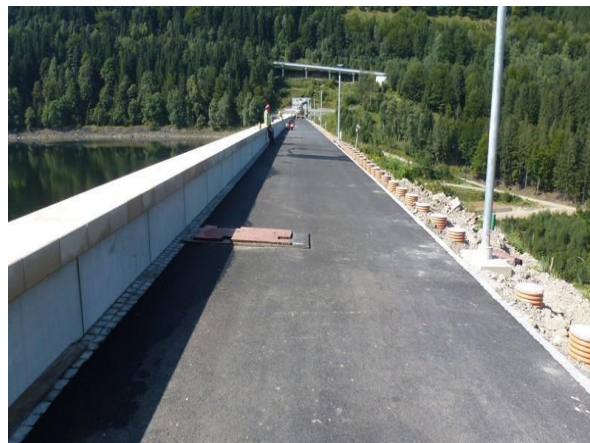
Obr.10 Koruna hráze po rekonstrukci
