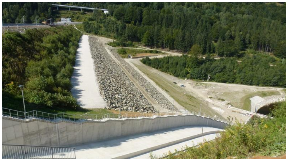
Obr.13 Stabilizační přísyp hráze
