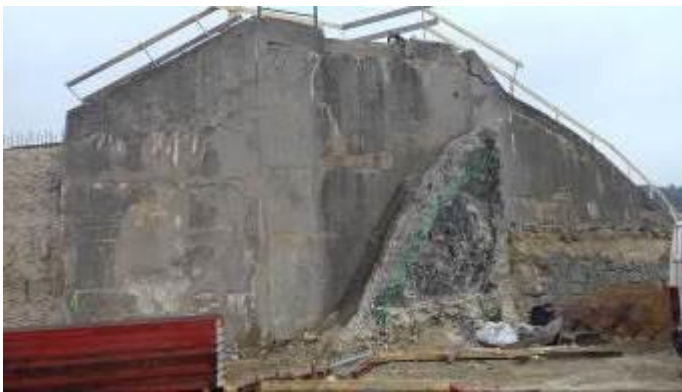
foto. 24 a foto 25: bourání přelivné plochy – patrný původní tvar na zbytku pravé stěny a odběry vzorků při betonážích
