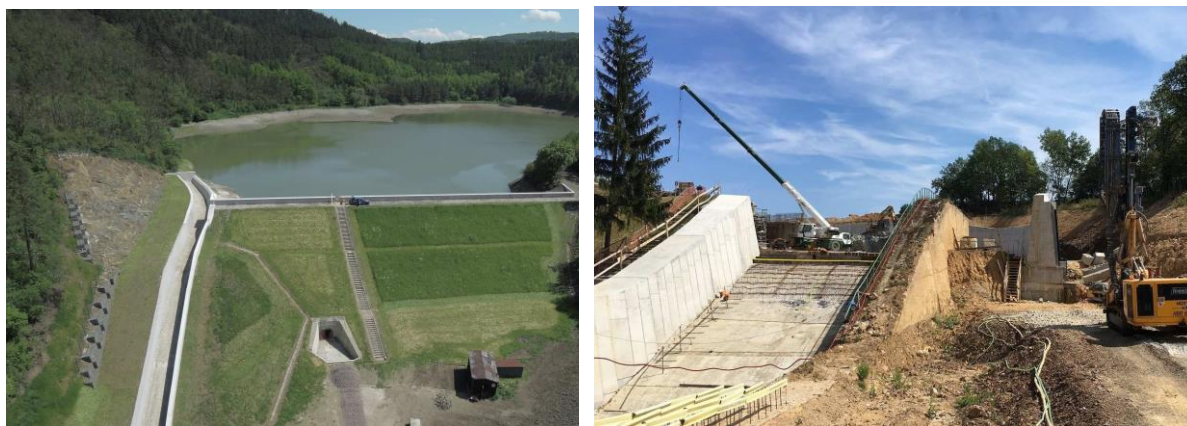
17)VD Suchomasty – zvýšení bezpečnosti, rozšíření bezpečnostního skluzu o bermu 2014 18)VD Klabava – zvýšení bezpečnosti, rozšíření bezpečnostního přelivu a skluzu 2018
