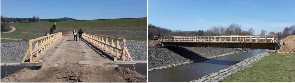
foto. 8 a foto 9: příprava staveniště – provizorní přemostění
