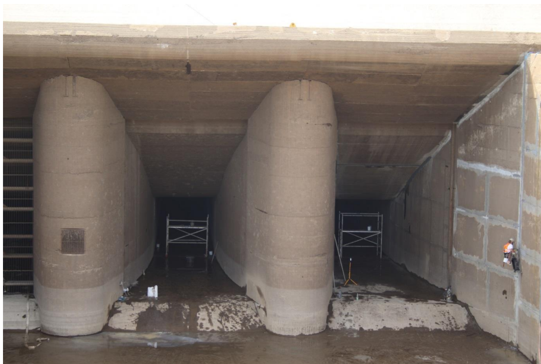
Obrázok č. 11 Vtokový objekt s betónovými privádzačmi P1 a P2 počas opráv.
