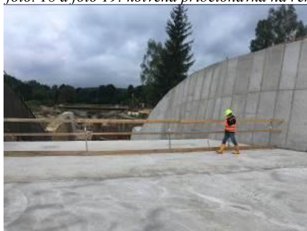
foto. 20 a foto 21: podkladní beton pod betonovou desku skluzu od přelivu chránící před škodami při případném převádění povodní za stavby, do něj kotvy pro vyvážení výztuže samotné železobetonové desky skluzu
