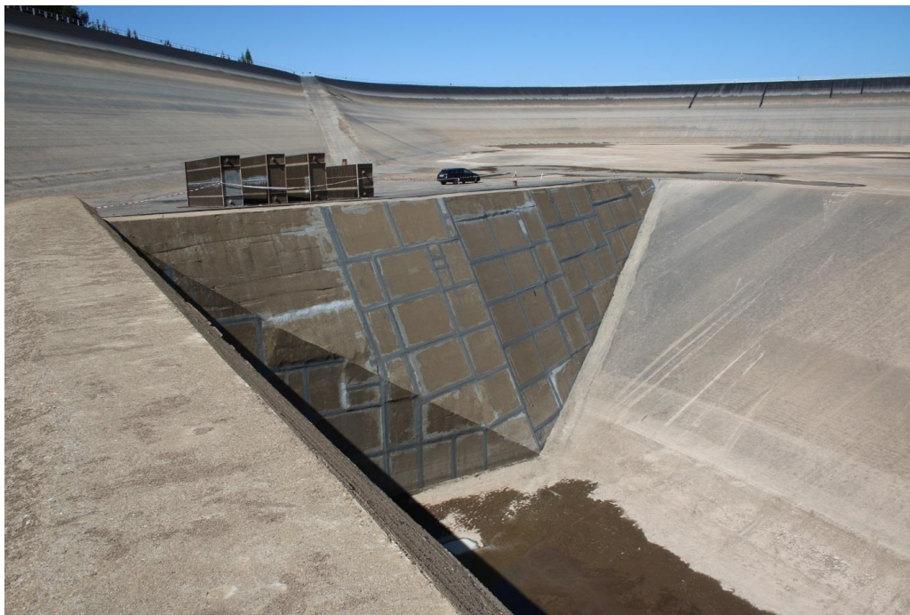
Obrázok č. 13 Dilatácie medzi železobetónovými blokmi strateného debnenia pravého vtokového krídla po ukončení opráv.
