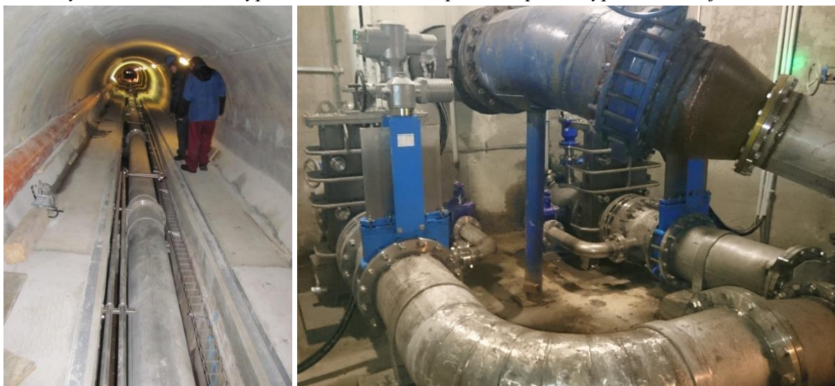
Obr.: Nové potrubí spodní výpusti v odpadní štoli a ve strojovně včetně nových uzávěrů.
