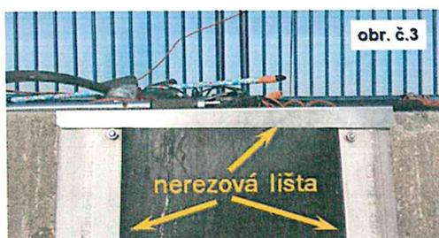
Na oboch okrajoch gumených pásov sa nachádzajú 10 cm-ové penové vyrovnávacie pásy (obr. č.1), ktorými je gumený pás prichytený pomocou nerezových líšt mechanickými kotvami na betónový múr (obr. č.2). Tieto svojimi vlastnosťami kopírujú nerovnosti betónového povrchu (predom vyčisteného) a tým zamedzujú styk dilatačnej škáry s vodou.
